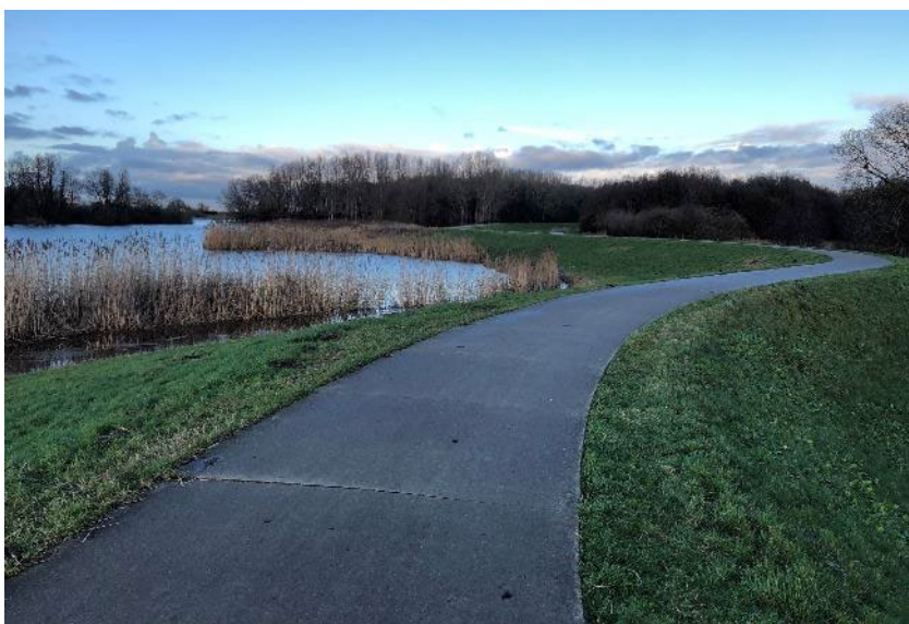
Foto 3.10: Waterkering langs de Westerveldse kolk
