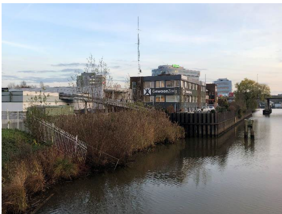
Foto 3.5: Oeverconstructie van stalen damwand en groene oever aansluiting Blaloweg
