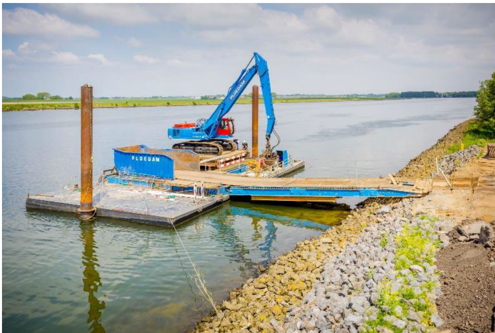
Figuur 6.2 voorbeeld Laad – los voorziening
