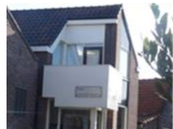
Balkons aan de voorzijde niet toegestaan
