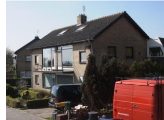
kenmerkend is, namelijk hout (voor gevel, kozijnen en deuren), metselwerk en keramische dakpannen
