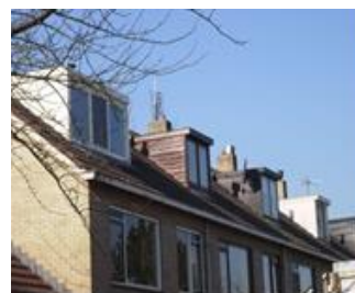
Een situatie waarbij geen eenheid zit tussen de vormgeving van de dakkapellen en de stijl van het gehele woningbouwblok
