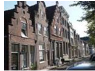
De kleinste en bepalende eenheid is een pand en maakt deel uit van een gevelwand
