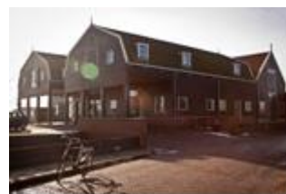
Dakkapellen in dezelfde stijl uitgevoerd als het hoofdgebouw
