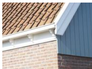
Het materiaalgebruik dient volgens traditioneel gebruik te zijn: hout, metselwerk en keramische dakpannen
