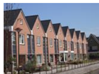
Aanpassingen aan een rijtjeswoning dienen in relatie te staan tot het gehele woningblok
