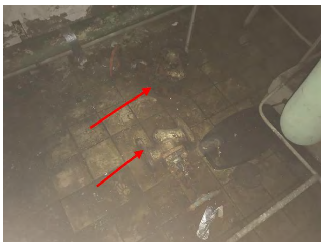
Foto 34 | Foto voor bron Pakkingen(los op afsluiters)) op vloer
