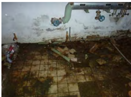
foto 29, aanzicht ruimte onderstation
