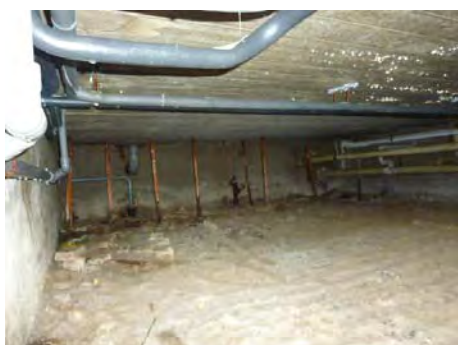
foto 19, aanzicht onderzochte kruipruimte
