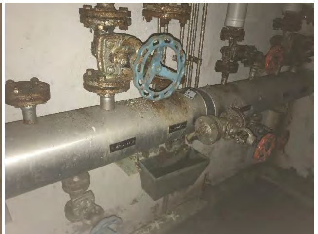
Foto 15 | Foto voor bron Flens verbindingen (pakkingen)
