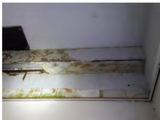
Foto 55 | Foto voor bron Stopverf kozijnen
