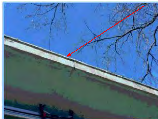
Foto 53 | Foto voor bron Bitumineuze dakbedekking
