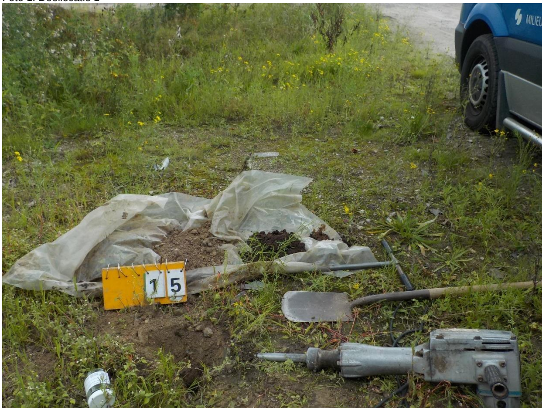
Foto 2: Boring 15 met behulp van breekhamer deellocatie 1
