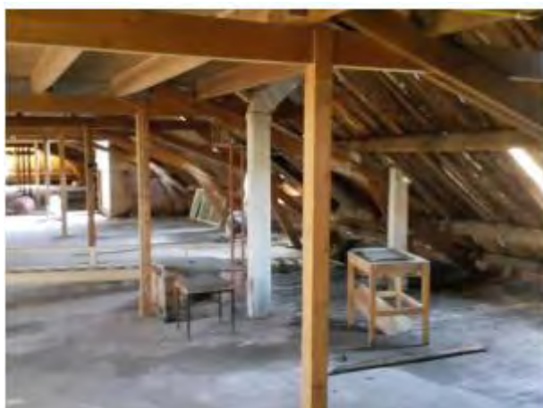
Foto 46 | Foto voor bron ventilatiekanalen
