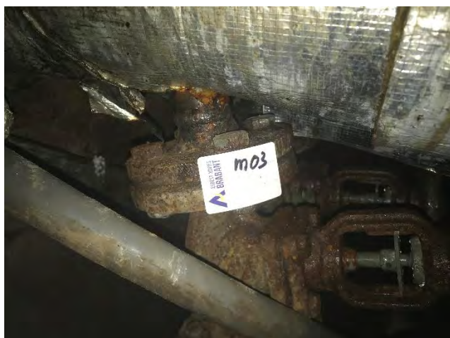
Foto 10 | Foto voor bron Flens verbindingen (pakkingen)
