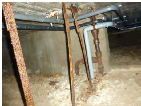
foto 25, aanzicht onderzochte kruipruimte
