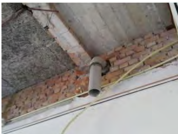
Foto 54 | Foto voor bron Ontluchtungskanaal
