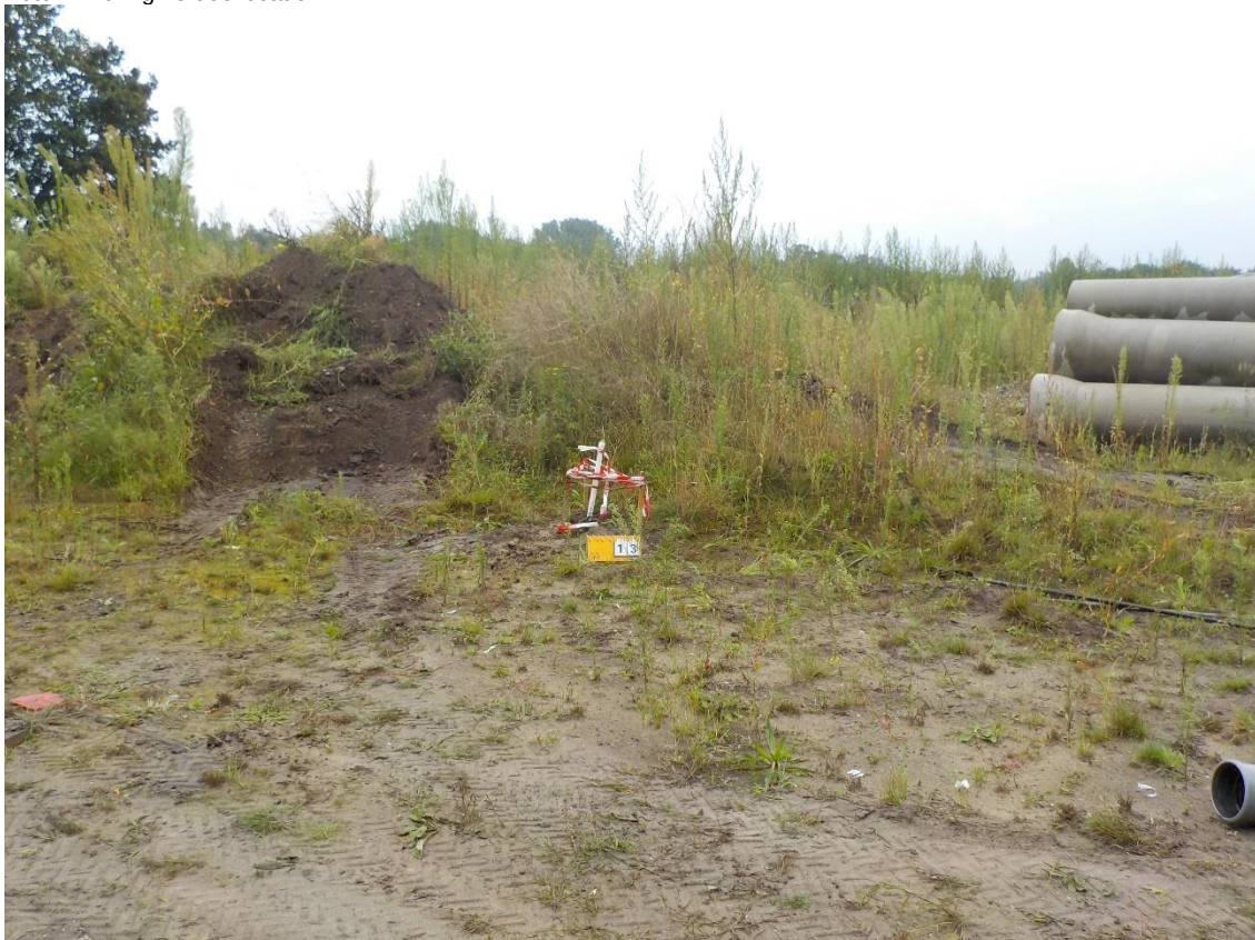
Foto 8: boring 13 met peilbuis deellocatie 3
