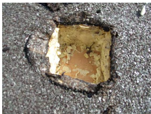
Foto 57 | Foto voor bron Bitumineuze dakbedekking
