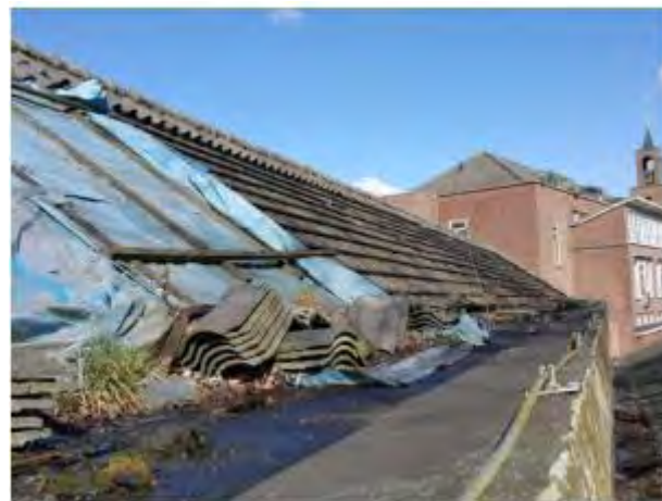
Foto 51 | Foto voor bron Bitumineuze dakbedekking goot
