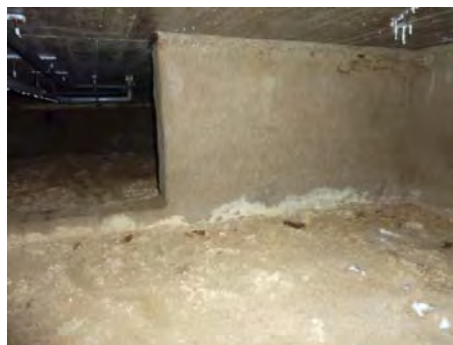
foto 26, aanzicht onderzochte kruipruimte
