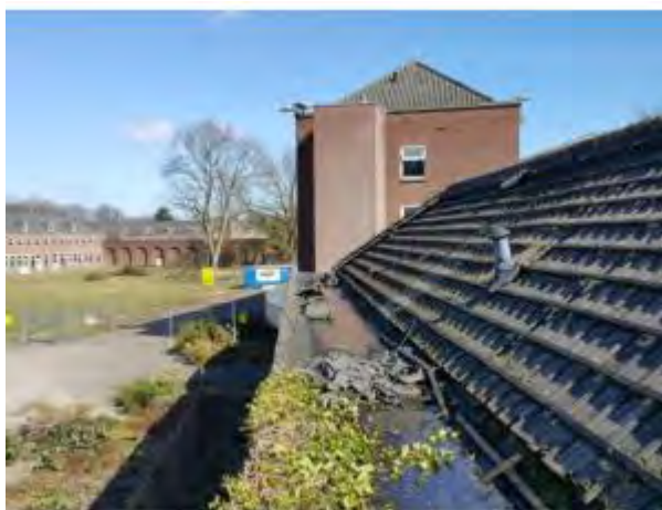
Foto 50 | Foto voor bron Bitumineuze dakbedekking goot
