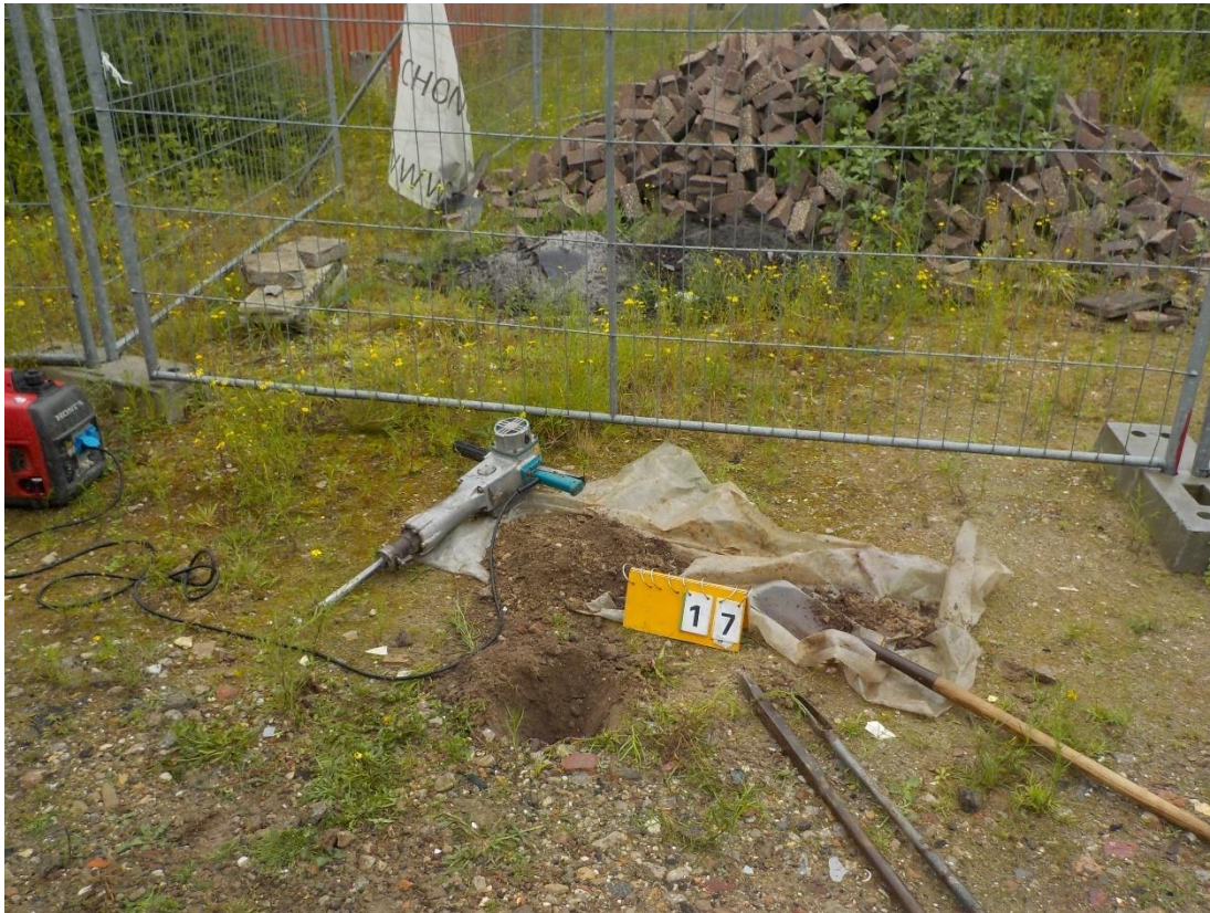
Foto 3: Boring 17 met behulp van breekhamer deellocatie 1
