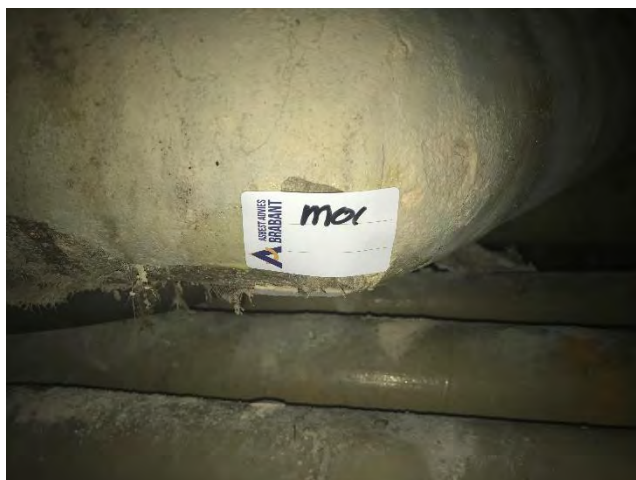
Foto 1 | Foto voor bron leidingisolatie kruipruimte 6, gang, onderstation
