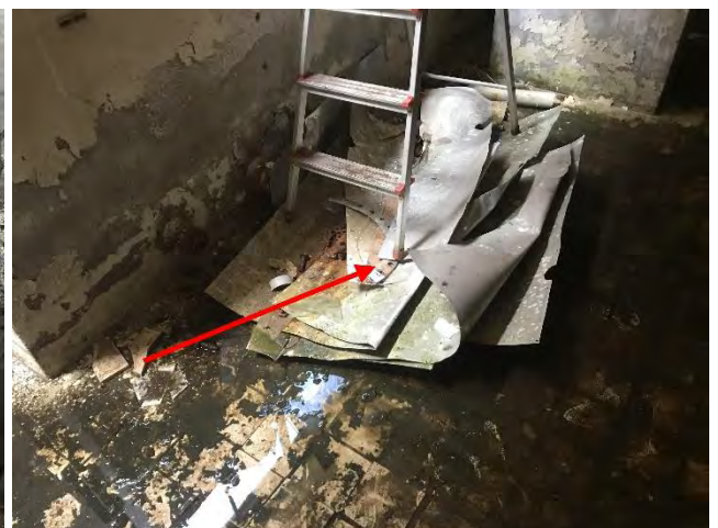
Foto 33 | Foto voor bron Pakkingen(los) op vloer
