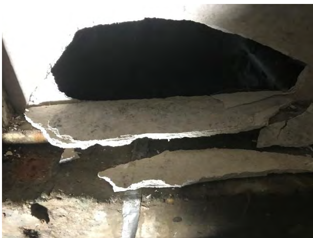
Foto 17 | Foto voor bron Plaatmateriaal in kozijn gang kruipruimte
