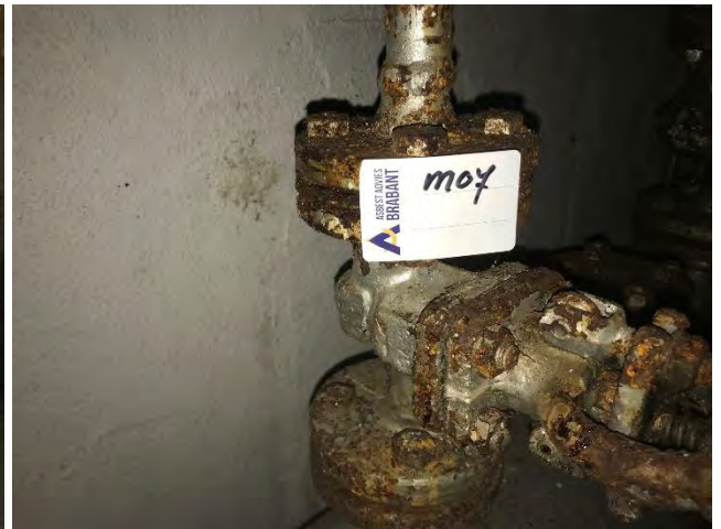
Foto 13 | Foto voor bron Flens verbindingen (pakkingen)
