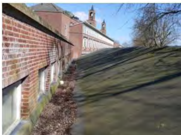
Foto 52 | Foto voor bron Bitumineuze dakbedekking
