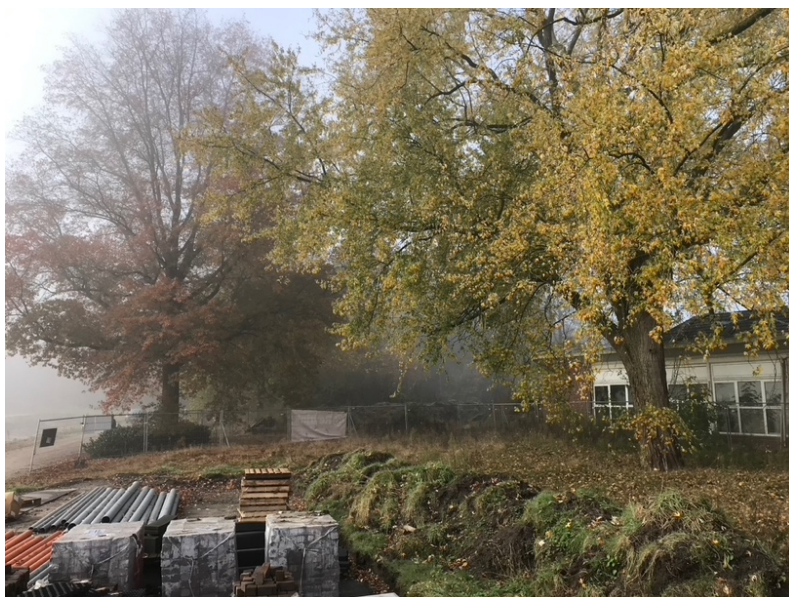
Foto 6 overzicht doorgang nieuwe locatie
