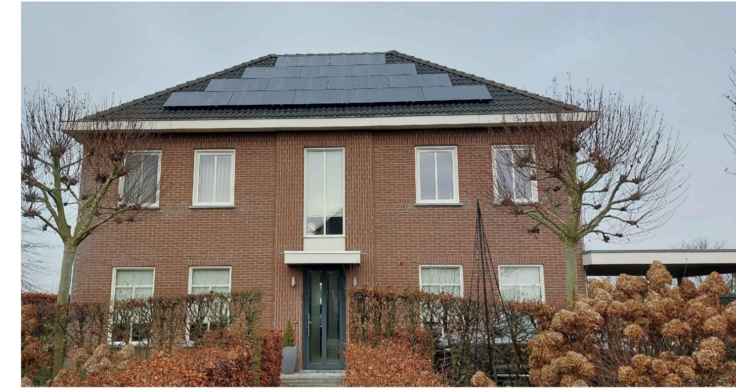
Foto bestaande situatie
