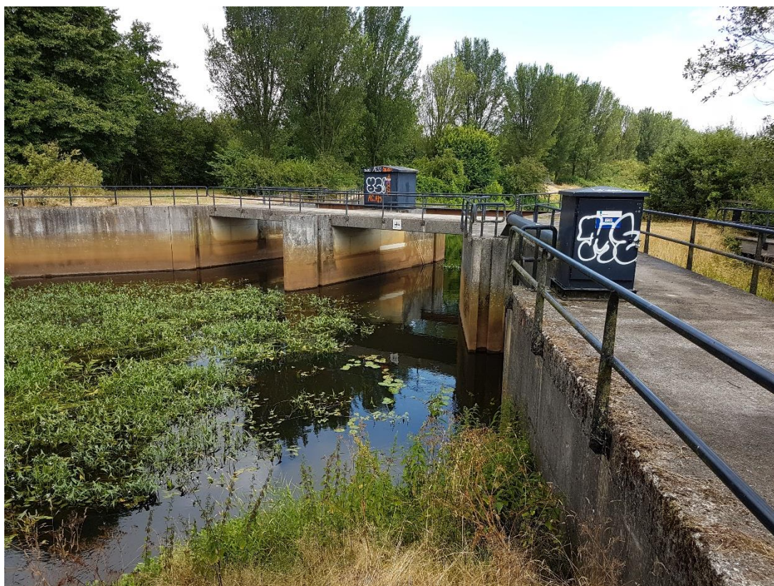
Figuur 2.10 Voormalige stuw Archem
