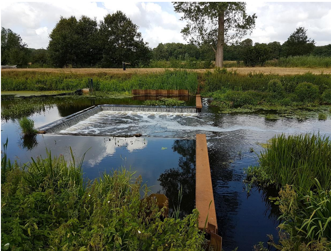
Figuur 2.11 Tijdelijke stuw Archem met op de achtergrond de voormalige kade en het N2000-gebied Archemermaten
