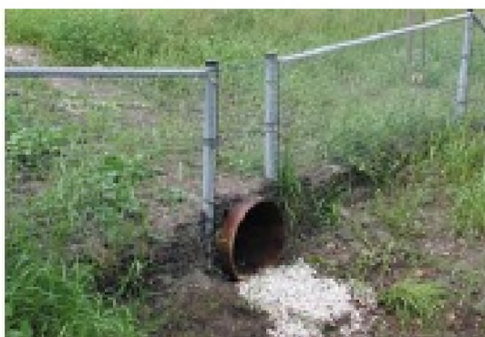
Figuur 12: een goede aansluiting van raster en dassentunnel is noodzakelijk (Bron: Handreiking faunavoorzieningen bij wegen)
