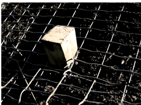
Abbeelding 7 Casanetgaas, dat met houten wiggen bevestigd wordt op het talud
