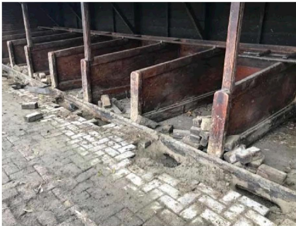
Afbeelding 3 verzakkingen in het straatwerk naast de stallen
