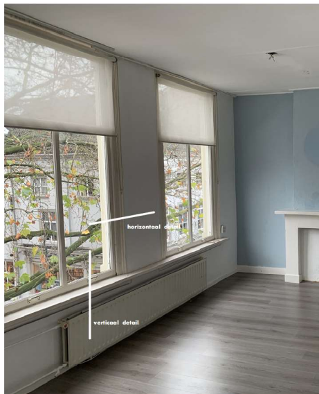
foto ramen voorgevel / bestaande toestand
