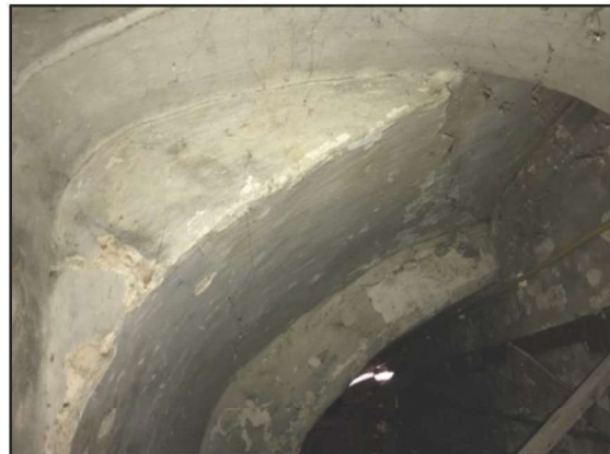
Afb. 26 [RB]: De linkerkzijde van de achterwand van de voorste en oudste kelder: meerdere generaties doorgangen spelen door elkaar.
