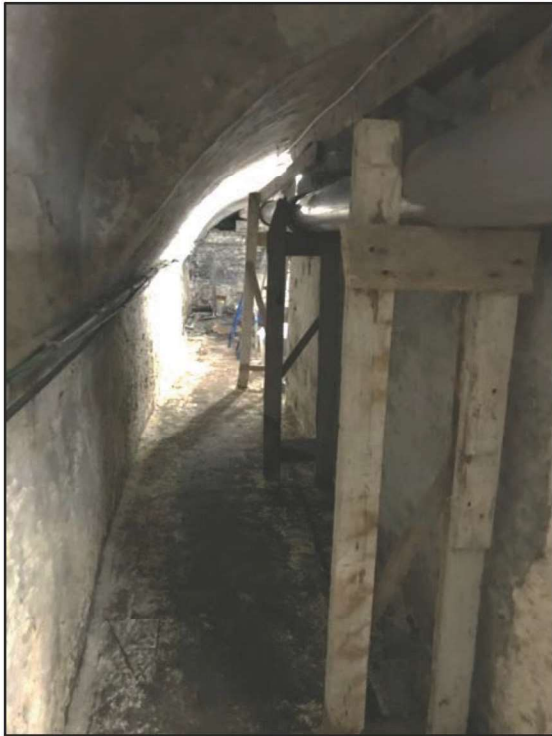
Afb. 25 [LB]: De verbindingsgang aan de linkerkant, naar achter gezien.
