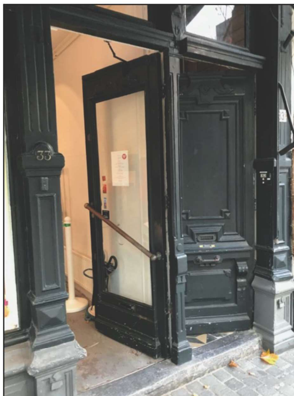
Afb. 14: De twee voordeuren: 'in principe' nog 19de-eeuws. De winkel deur heft een grote ruit en een handgreep gekregen.
