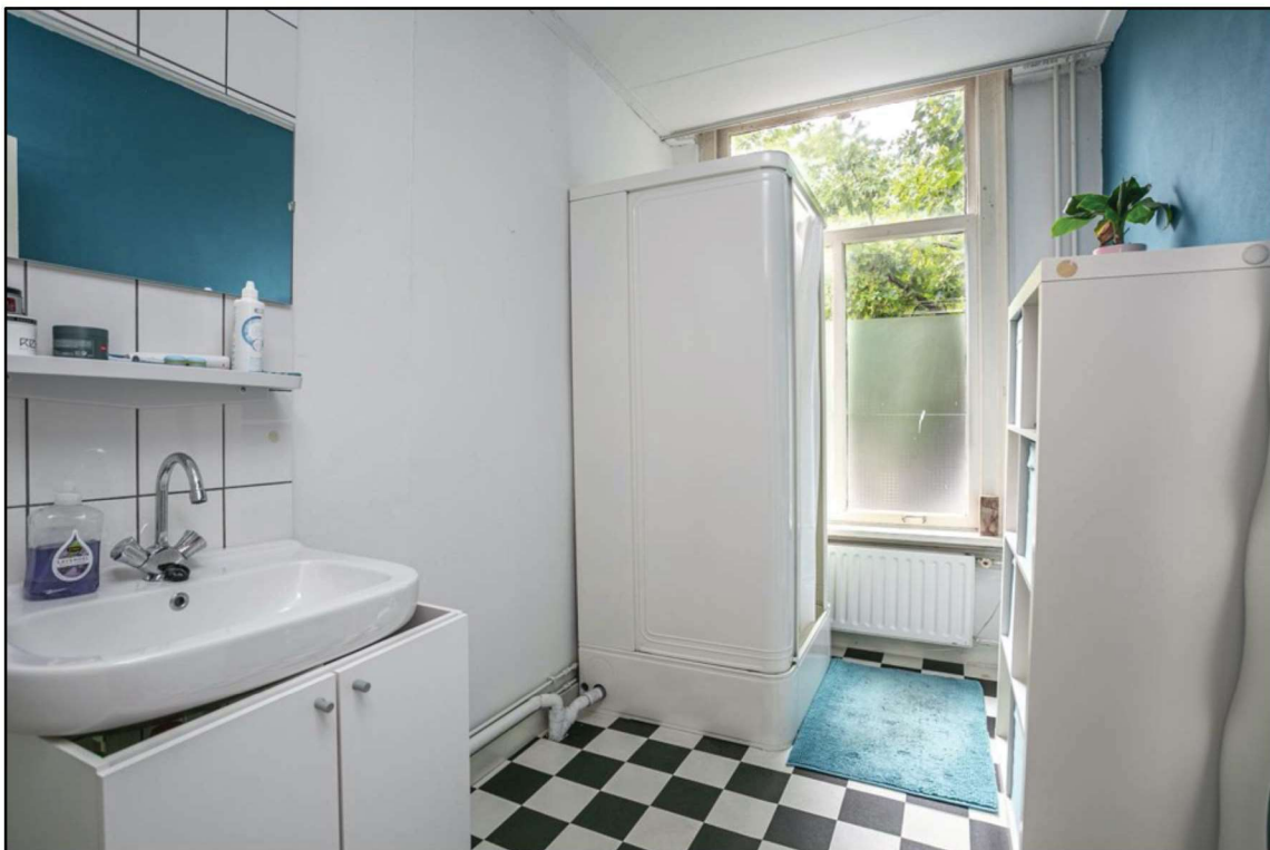
Afb. 42: De badkamer rechtsvoor naar de voorgevel
