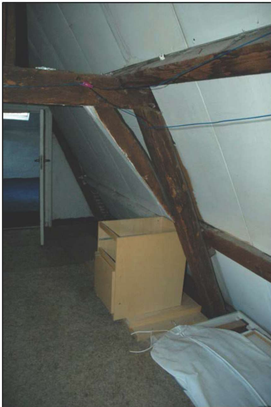
Afb. 56 [LB]: De middelste ruimte op de vlieringzolder; linkerdeel van het bovenjuk van het tweede spant, naar voor.
