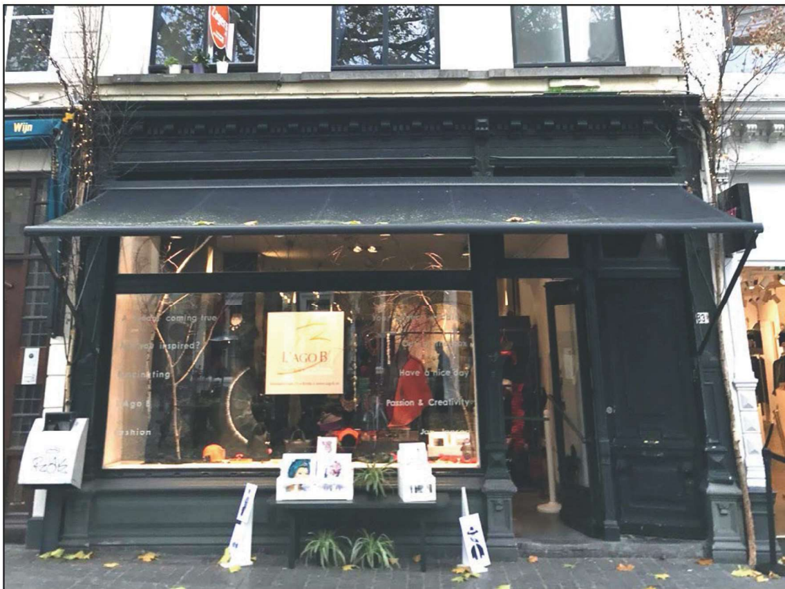
Afb. 13: De onderpui anno 2020.
