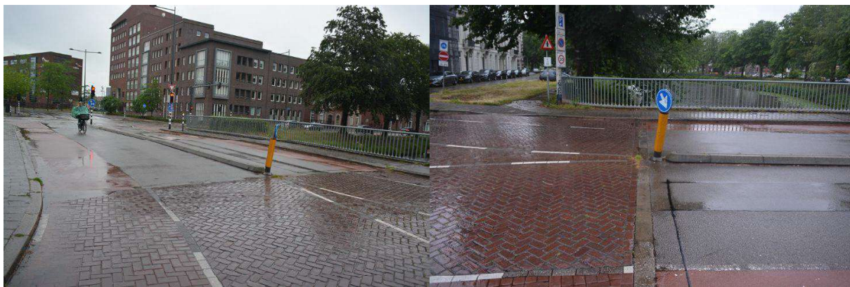
Straatbeeld op Mauritsbrug en ter plaatse van voegovergangsconstructie
