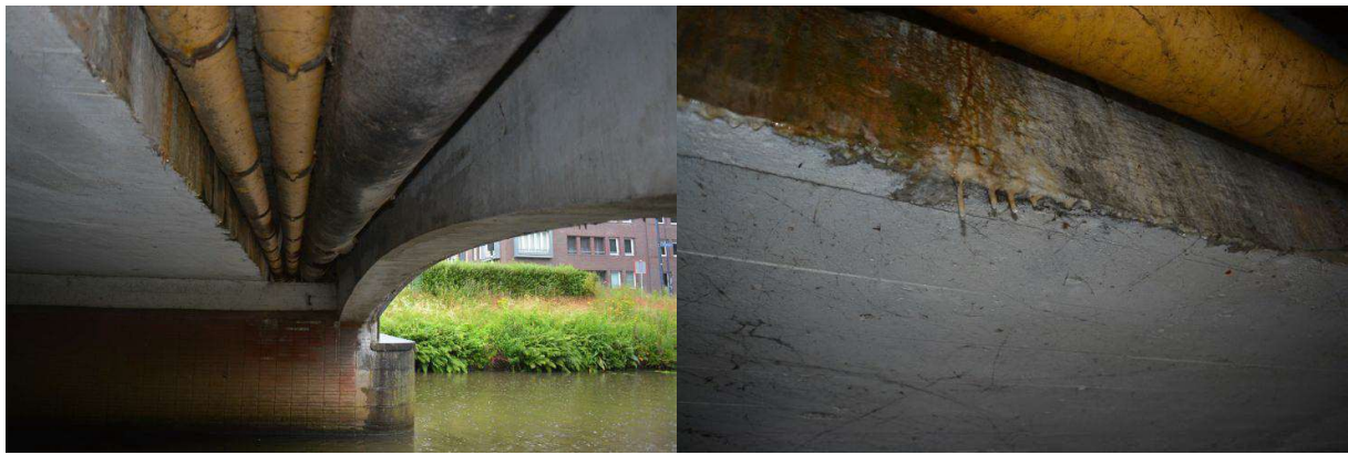
Inkassing met leidingen en hoge vochtbelasting van bovenaf
