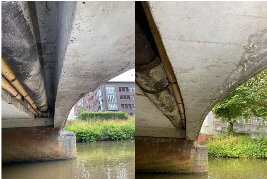
Inkassing met leidingen en hoge vochtbelasting van bovenaf
