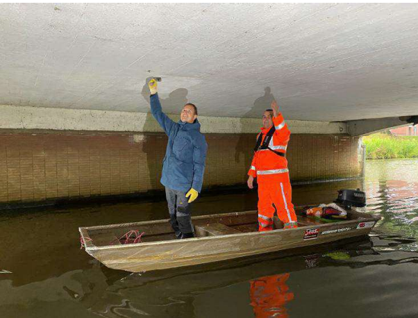
Inspectie en afkloppen oppervlak
