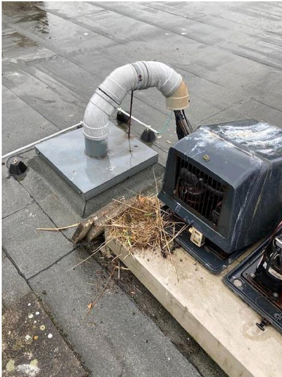
Figuur 24: Meeuwenontlasting en nestmateriaal op dakinstallatie bedrijfspand Alkmaar (foto: [REDACTED])
