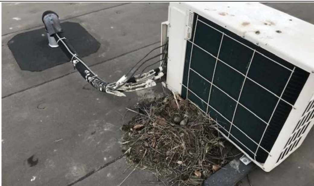
Afbeelding 8: Nest tegen airco aan waarbij de broedende meeuw de bekabeling heeft aangepikt met grote kans op brandgevaar.
