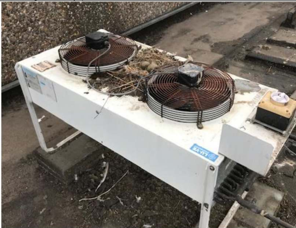
Afbeelding 7: Nest op koelvoorziening dak.
