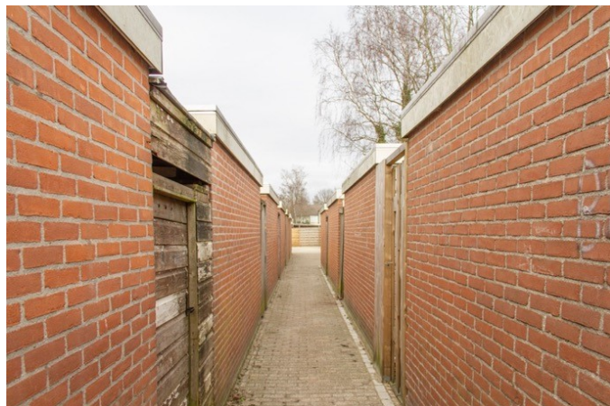
Foto: Zuidlaarderbrink in Emmen. Achterpad van de gemeente dat niet verlicht wordt.
