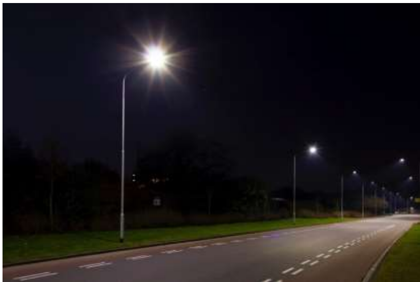
Foto: Brinkenweg in Emmen. Het licht is gelijkmatig over de weg verdeeld.
