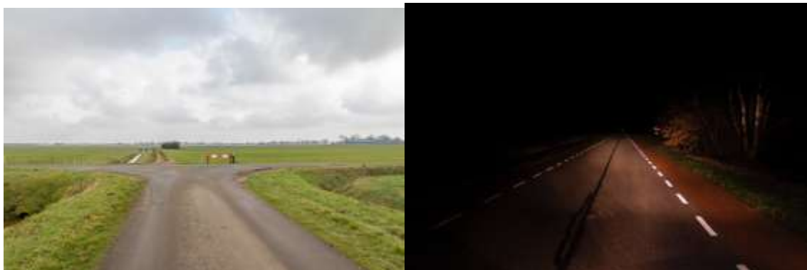
Foto: links een schrikhek en rechts reflecterende belijning. Twee voorbeelden van alternatieven in plaats van verlichting.
