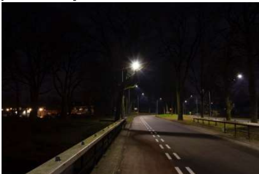
Foto: Brinkenweg in Emmen, lantaarnpaal staat in de boom en geeft niet voldoende licht meer op de weg.
