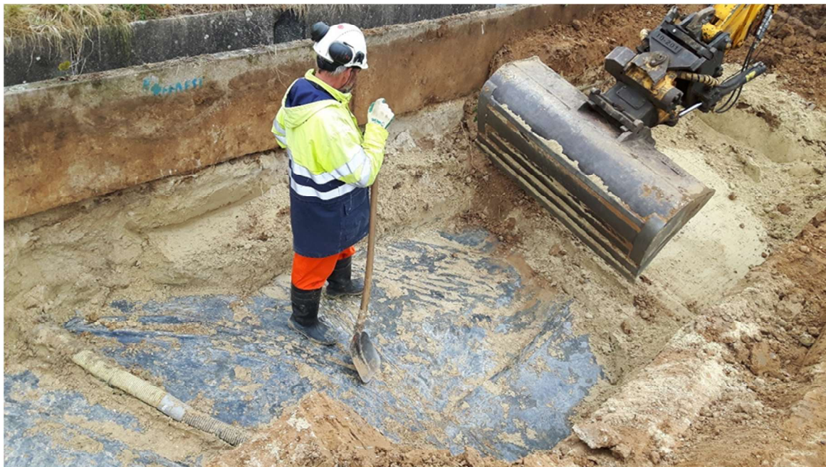
Fig. 4.3 Afgraving tot op de folieconstructie; op de folieconstructie ligt drainageslang, lichtgekleurd drainagezand en een donkerder gekleurde leeflaag; locatie 1.
