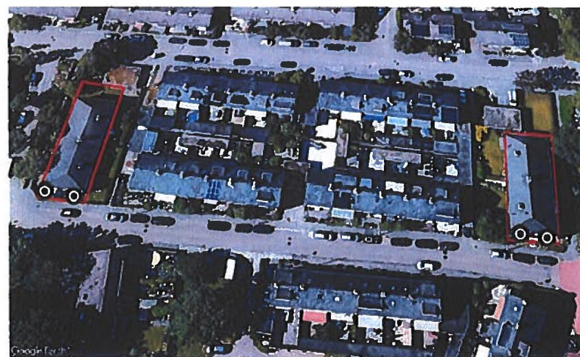
Figuur 9: Permanente alternatieve verblijfplaatsen van de ruige dwergvleermuis in complex 7038
