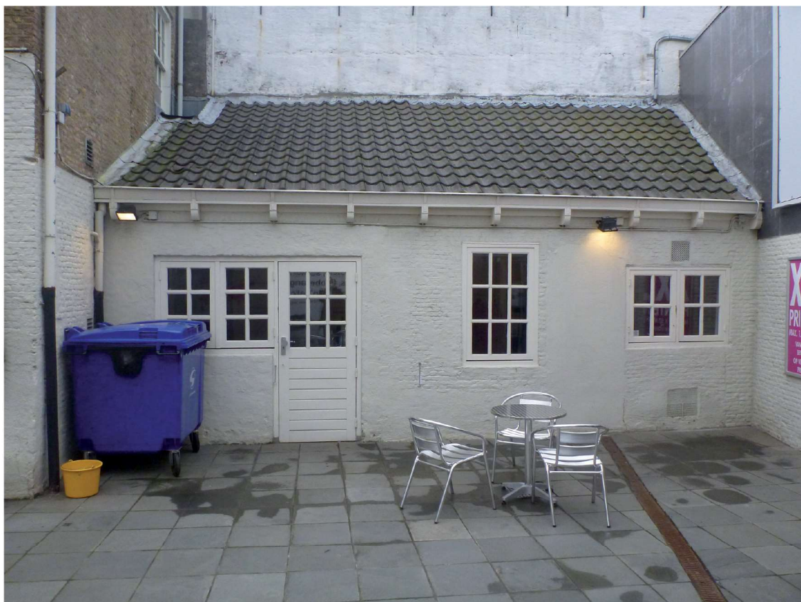
Afb. 15 De lage aanbouw achter het achterhuis
