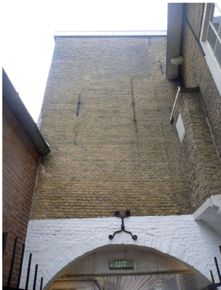
Afb. 8 De achtergevel van het voorhuis boven de poort, met de sporen van een dichtgezet venster
