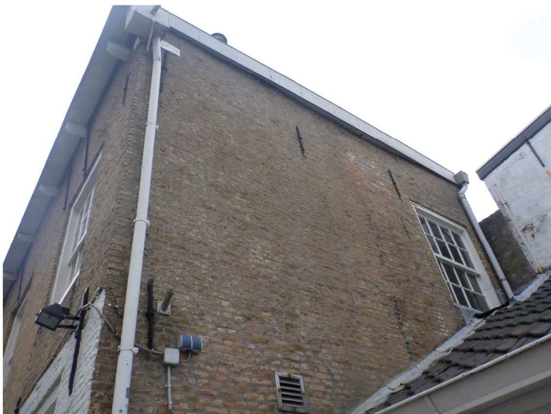
Afb. 14 De achtergevel van het achterhuis
