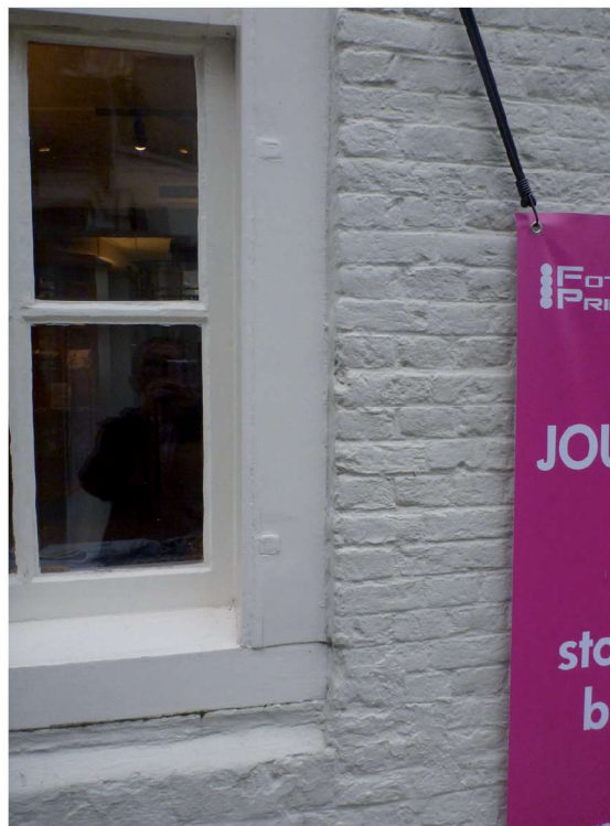
Afb. 13 Sporen van de duimen in de kozijnstijl van een van de vensters op de begane grond
