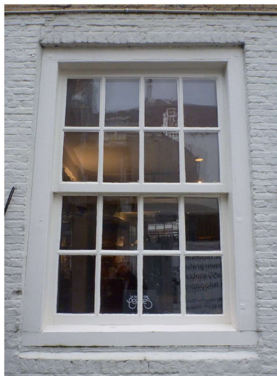
Afb. 12 Een van de gewijzigde vensters in de zijgevel van het achterhuis
