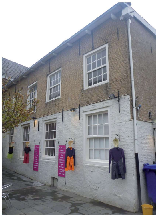
Afb. 10 De rechterzijgevel en de achtergevel van het achterhuis
