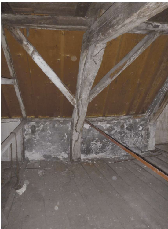
Afb. 23 Een van de hergebruikte eiken spanten
