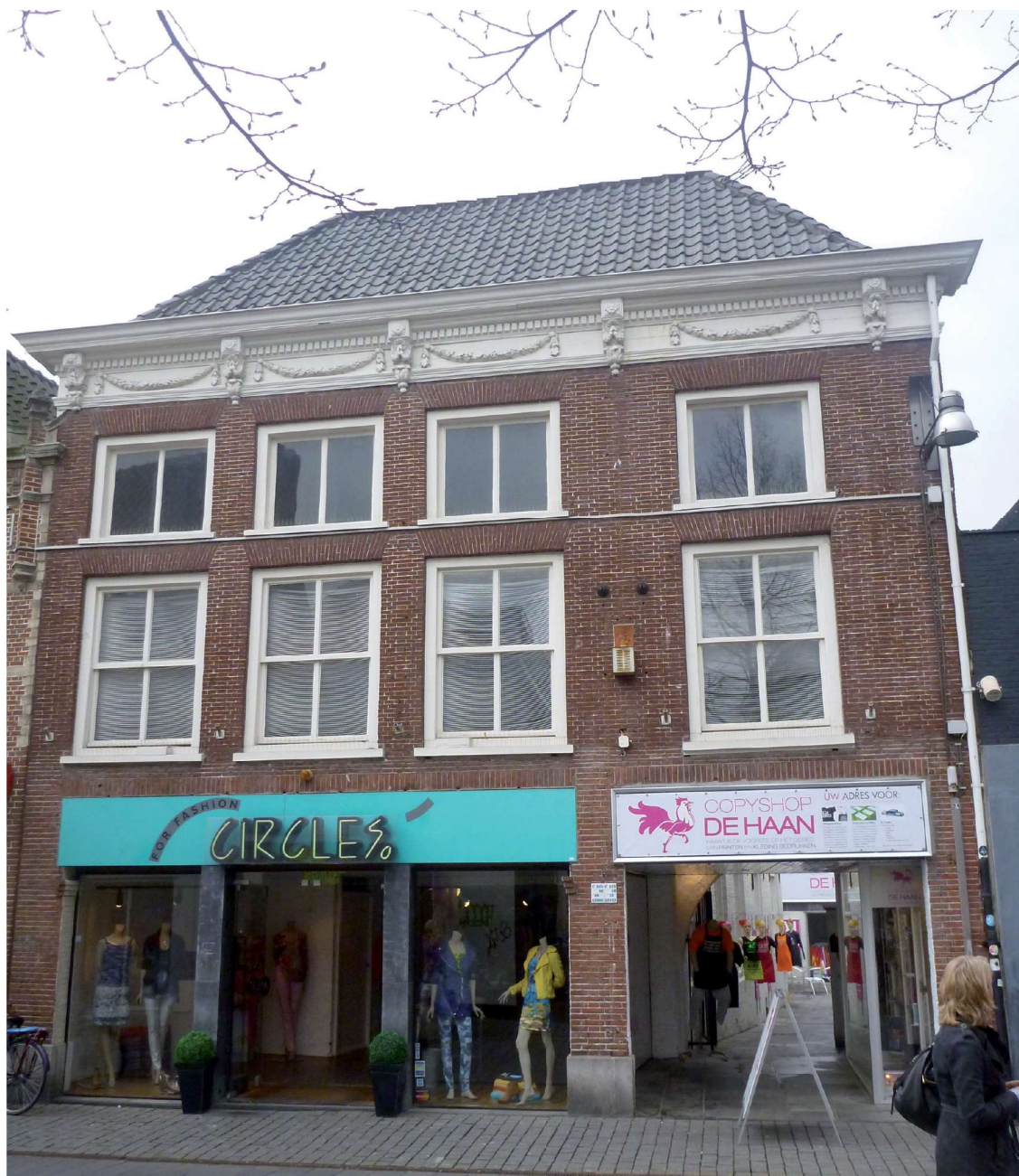
Afb. 7 De voorgevel gezien vanuit de Stallingstraat
