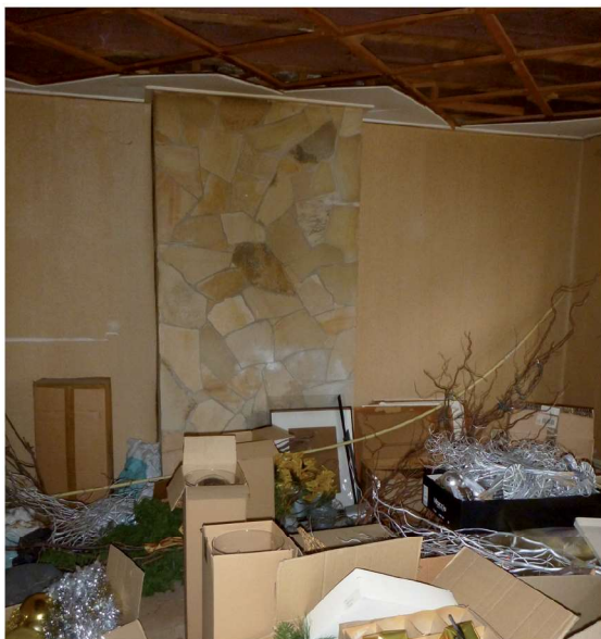
Afb. 16 De schouwpartij in de rechtervoorkamer op de eerste verdieping
