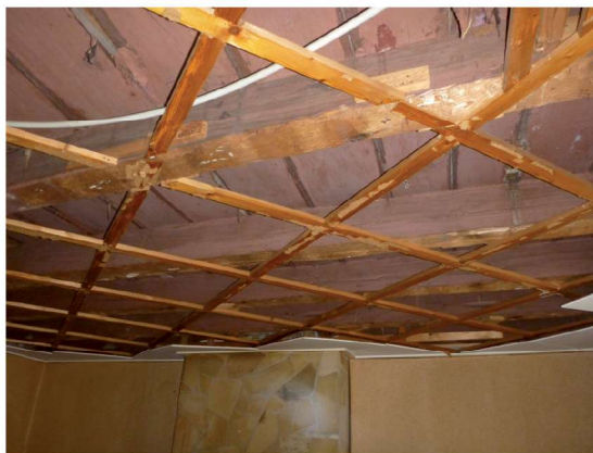
Afb. 17 De geschilderde balklaag in de rechtervoorkamer op de eerste verdieping
