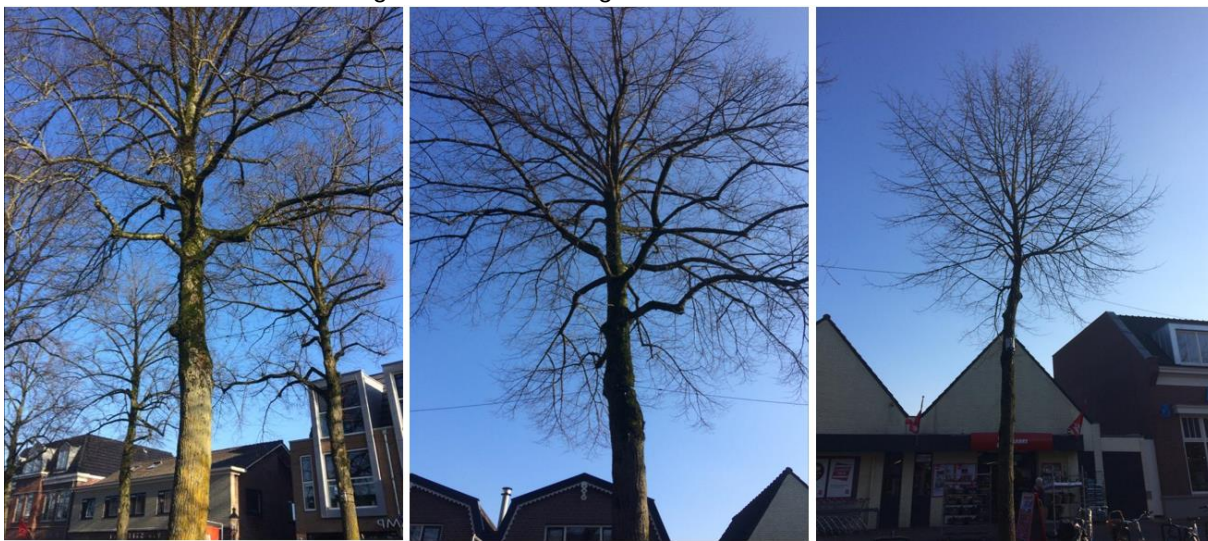
fig. 11: de bomen binnen de versturende invloedssfeer zijn gecheckt op holtes, scheuren en losse schors, dit is niet aangetroffen
