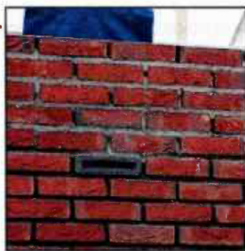
Figuur 10. Eindresultaat ingemetselde vleermuiskast (Bron: vivarapro).
