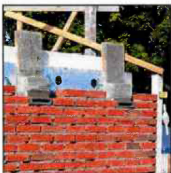
Figuur 9. Realisatie inbouwkasten in gevel (Bron: vivarapro).
