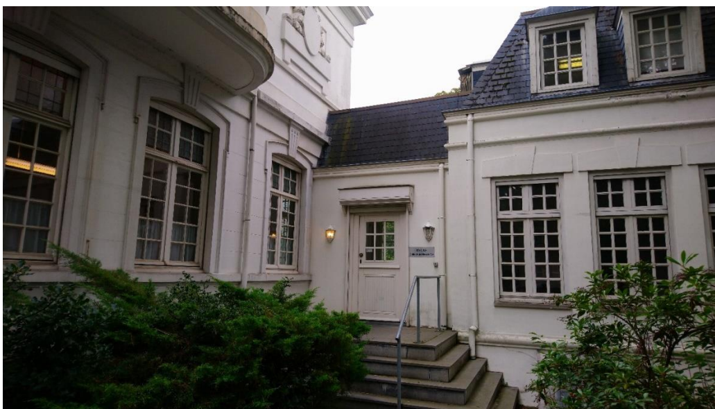
Foto 6 Het tussenlid tussen de villa en de aanbouw.
