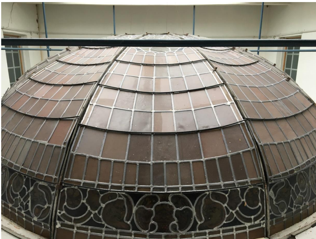
Foto 5 De glas-in-lood panelen van de lichtkap zakken door ten gevolge van te zwak gedimensioneerde brugstaven die niet goed gekoppeld zijn aan de gebogen binten tussen de glaspanelen.
