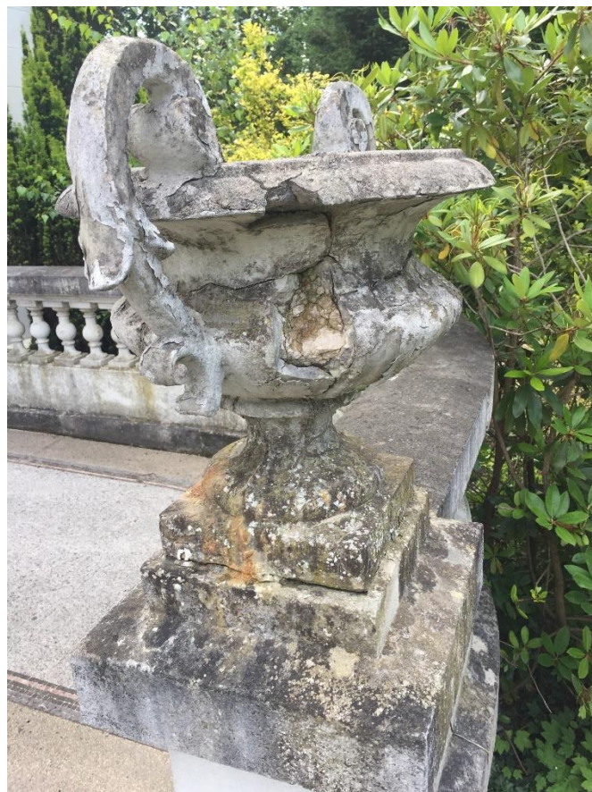
Foto 3 / 4 Sterk aangetaste baluster en kruik ter plaatse van de bordesbalustrade aan de westzijde van het gebouw.
