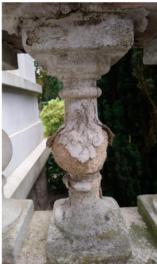
Foto 3 / 4 Sterk aangetaste baluster en kruik ter plaatse van de bordesbalustrade aan de westzijde van het gebouw.
