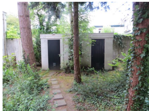
Afb. 1.17: Fietsenberging en betonnen schutting op noordelijke perceelsgrens. Links is nog net de hoek van de kantoorvleugel zichtbaar.
