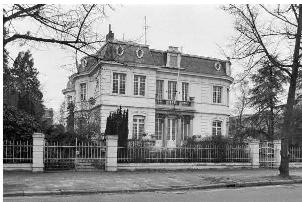
Afb. 2.24: Zicht op de voorgevel en tuinhek (links de oorspronkelijke uitrijpoort en rechts de kleine poort), 1978. (Bron: beeldbank.cultureelerfgoed.nl ; id.nr. 191358.)
