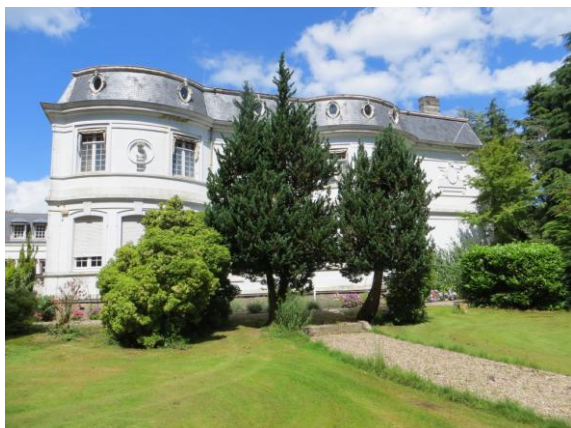
Afb. 1.18: Zicht op de zuidgevel van de villa. Op de voorgrond de verdiepte zijtuin, bereikbaar via een klein trapje vanaf het pad langs de villa.
