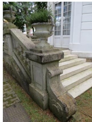
Afb. 1.15: Trap naar het terras op de noordoosthoek van de villa. De balustrade en tuinva-zen zijn uit beton vervaardigd.
