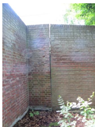
Afb. 1.40: Aansluiting van twee losse muurgedeelten, ter hoogte van de knik in de muur op de zuidwesthoek van het perceel.
