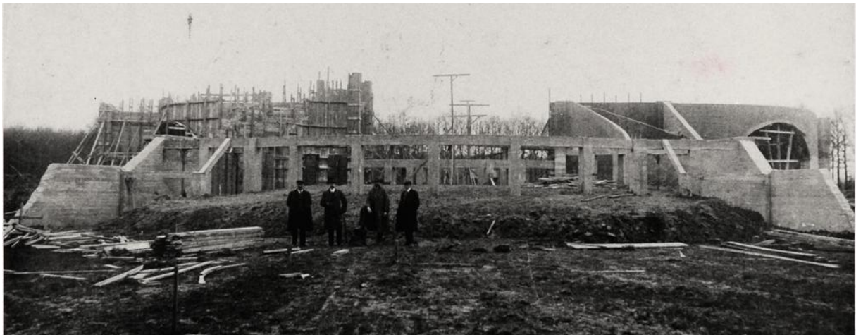
Afb. 3.4: Villa 'Pea-park' tijdens de bouw in 1913. De indrukwekkende betonnen constructie die aan de villa ten grondslag ligt is goed te zien. (Bron: www.thuisinbrabant.nl ; collectie Gemeente Helmond, fotonr. 100257.)
