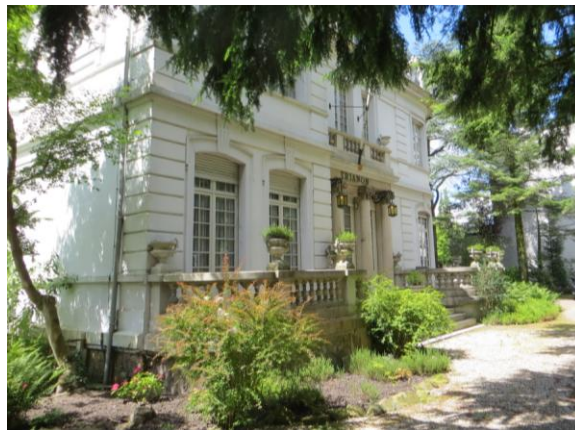
Afb. 1.5: Voorgevel (oostzijde) met trap en verhoogde terrassen. Voorlangs met natuurstenen rand afgewerkte borders.
