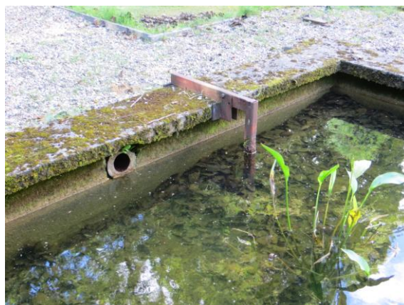
Afb. 1.21: In de westelijke vijverrand bevindt zich een metalen overstort. De bodem van de vijver is afgewerkt met een grindlaag.
