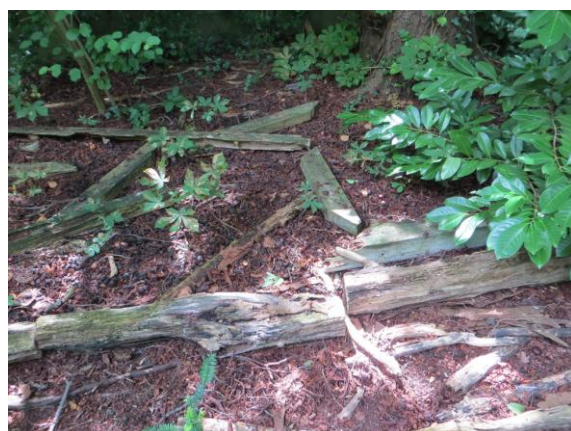
Afb. 1.28: Achter de pergola liggen in het bos restanten van de houten liggers.
