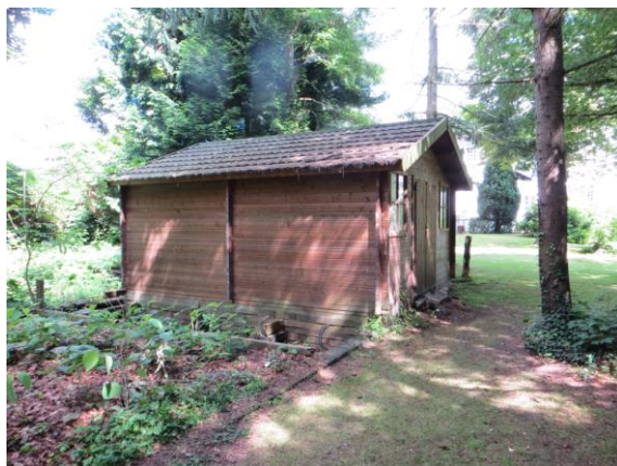
Afb. 1.45: Blokhut op ruimere (en oudere) fundering van baksteen. Rechts op de achtergrond de achtergevel van de kantoorvleugel.
