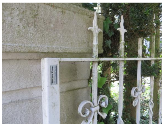
Afb. 1.11: Detailopname van het historiserende hekwerk waarmee de oorspronkelijke openslaande delen van de hoofdpoot zijn vervangen.
