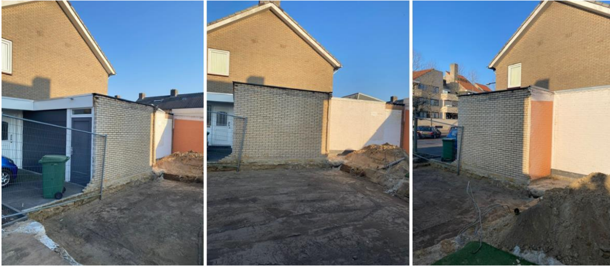
Reeds gesloopt bestaande aanbouw en instandhouding toegang naburige perceel
