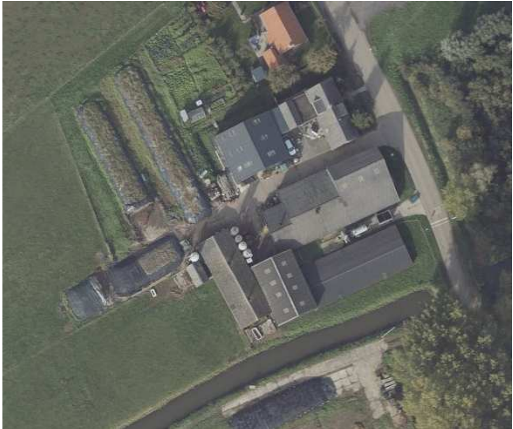
Figuur 1: luchtfoto projectlocatie Vlietskant 15 te Gellicum (bron: Google)
