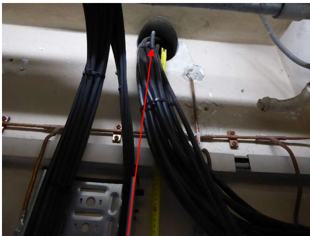
Bestaande kabeldoorvoer(en) en kabelgoot in kleur RAL 8003 (zie ook tekeningen) worden hergebruikt. De kabelgoot heeft dezelfde RAL als de toren
