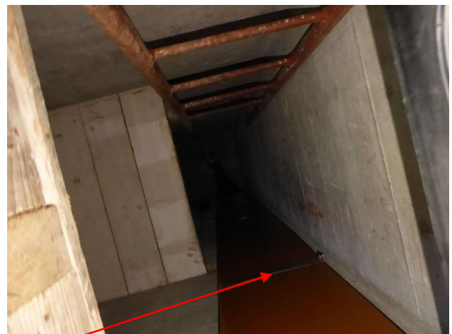
Bestaande kabeldoorvoer(en) en kabelgoot in kleur RAL 8003 (zie ook tekeningen) worden hergebruikt. De kabelgoot heeft dezelfde RAL als de toren
