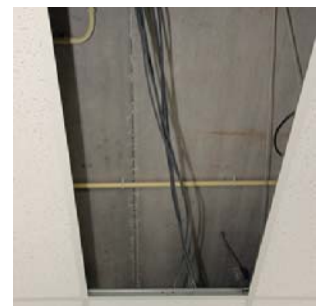
betonnen kanaalplaatvloer in uitbreiding nummer 52
