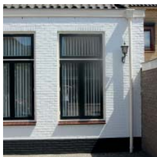
nieuwe kozijnen en metselwerk van de aanbouw van 52.
