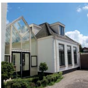
achterzijde serre en aanbouw (52)
