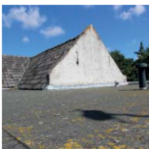
dakovergang vanuit nummer 52 naar Kerkstraat gezien.
