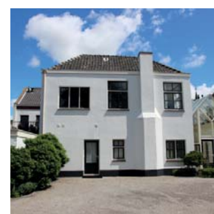
achtergevel nummer 54 met nieuwe kozijnen en schoorsteen
