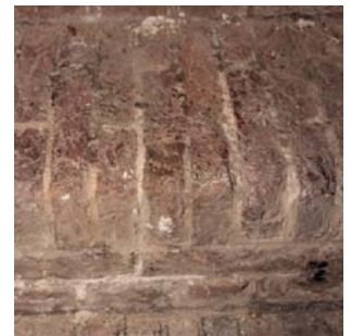
traptrede van de kelder
