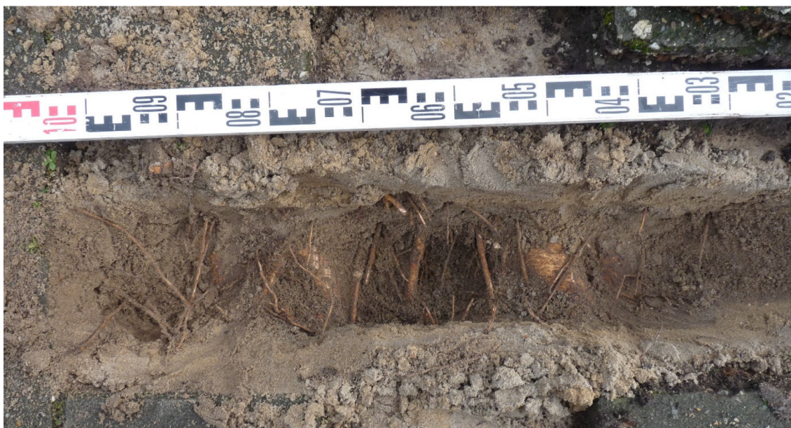
Afbeelding 20: Diverse stabiliteitwortels net onder de bol bestratte verharding
