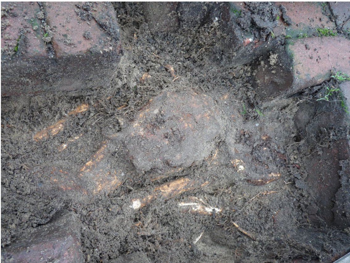
Afbeelding 16: Dikkere beworteling en beworteling met dik littekenweefsel direct onder de rijbaan
