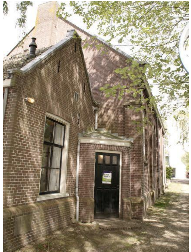
Linker zijgevel (achter )
