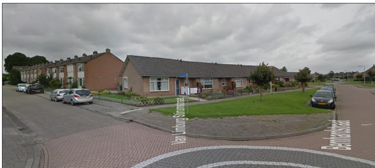
Afbeelding 2.2: Bestaande situatie kruising Bernhardstraat – Van Limburgstirumstraat gezien richting het noordwesten (bron: Google Street View, opnamedatum: augustus 2016).
