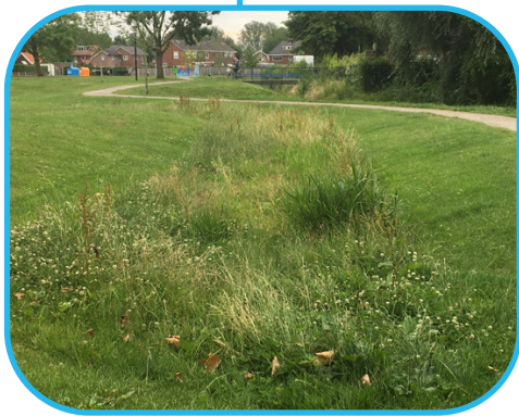
de wadis zorgen voor lokale infiltratie
