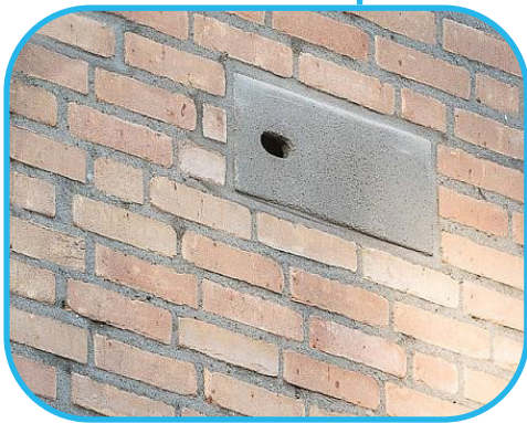
Inbouwkasten gierzwaluw en huismus op 3-4 meter hoogte
