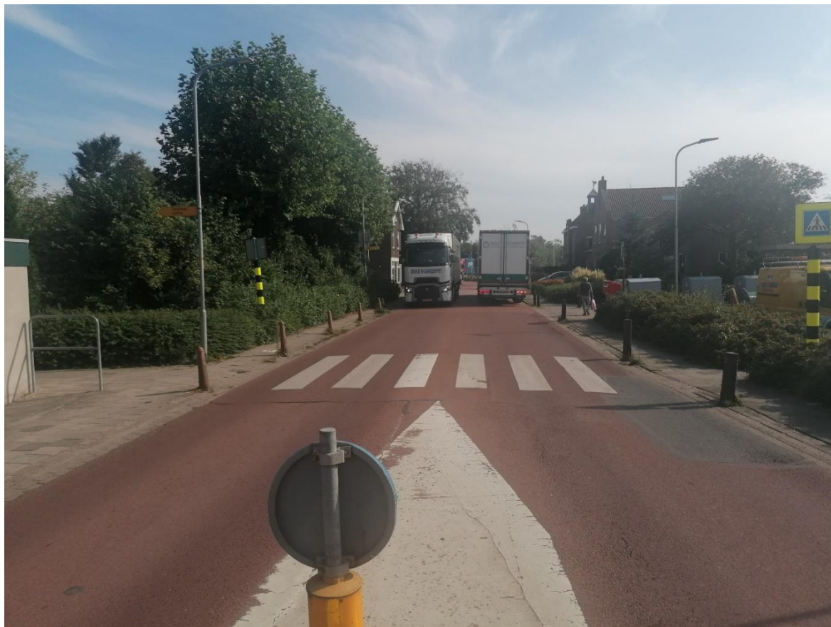
9 BOEKERT TUSSEN SPOORLIJN EN OOSTERBLOKKER (kijkrichting naar zuiden)
