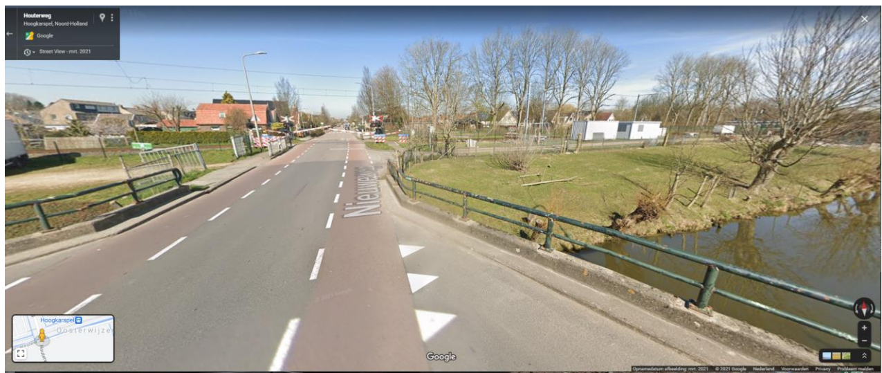
22 NIEUWEWEG TUSSEN WESTERWIJZEND EN SPOORLIJN (kijkrichting naar noorden)
