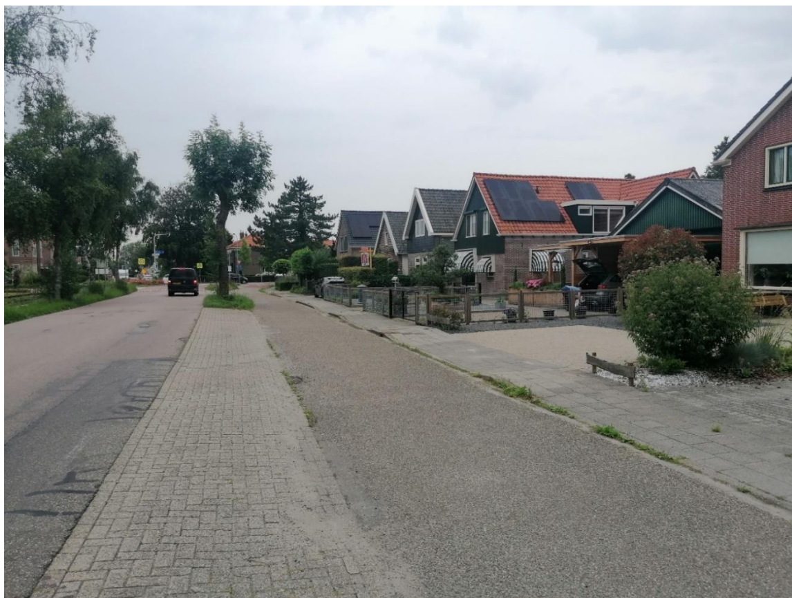
3 ZUIDERDRACHT tussen VEILINGWEG EN GILDENWEG (kijkrichting naar noorden)
