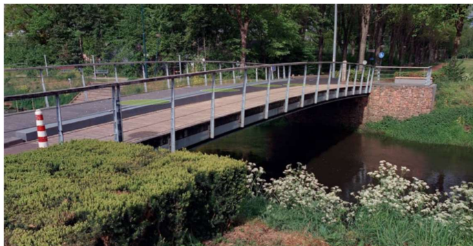
Figuur 2: Aanzicht bestaande brug
