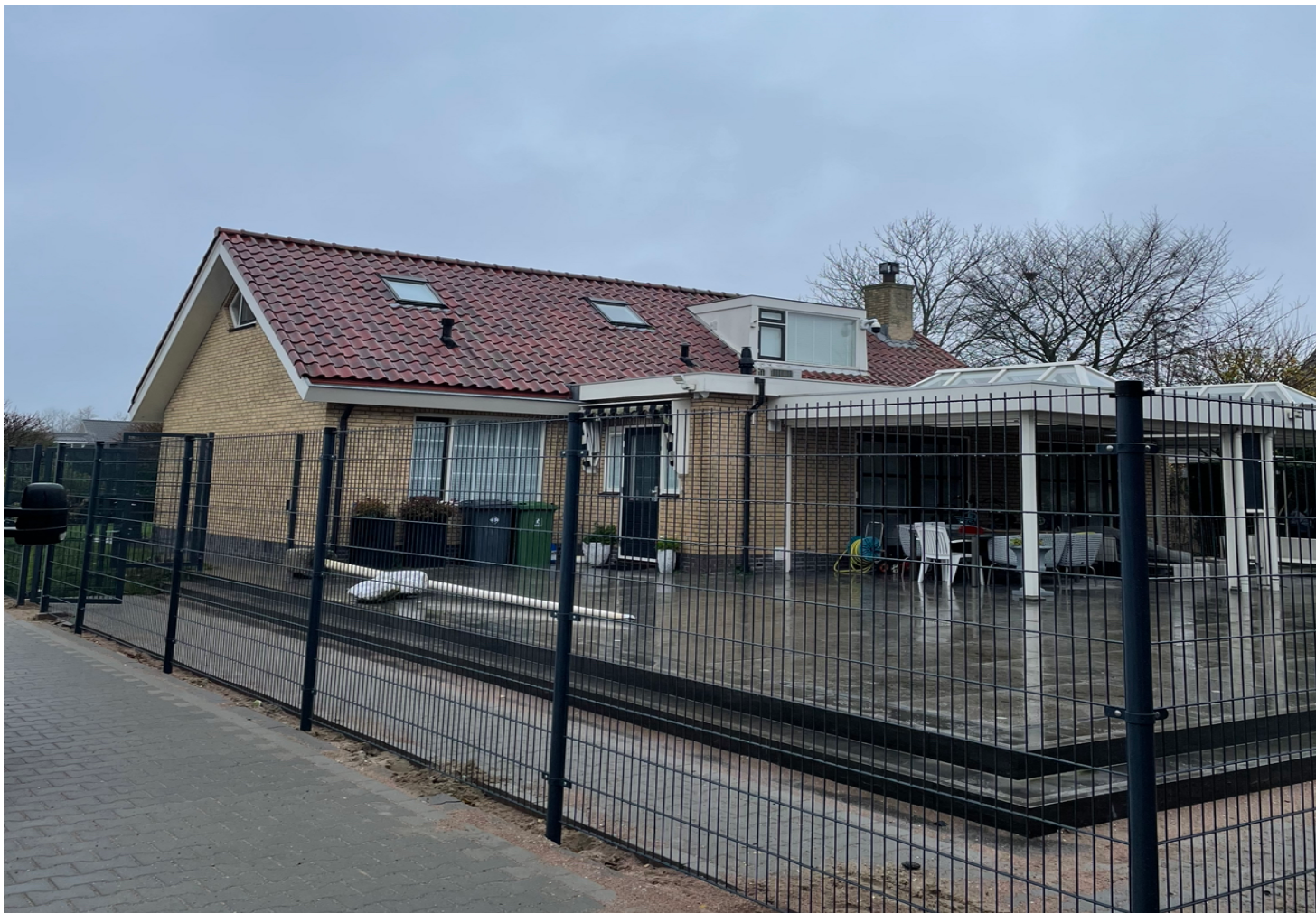
Foto bestaande achtergevel
