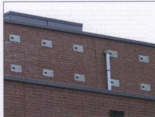
IB GZ 01 kasten ingemetseld in de gevel
