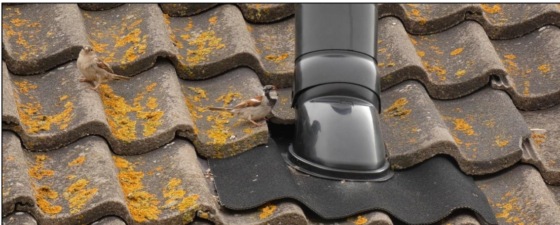
Figuur 8: Gaten in het dak rondom de schoorsteen waar huismussen onder de dakpannen kunnen komen.
