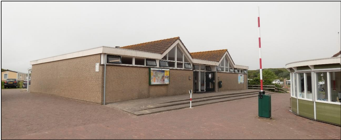
Figuur 2: Twee van de te slopen opstallen zijn opgetrokken uit baksteen met een dakpannen dak.
