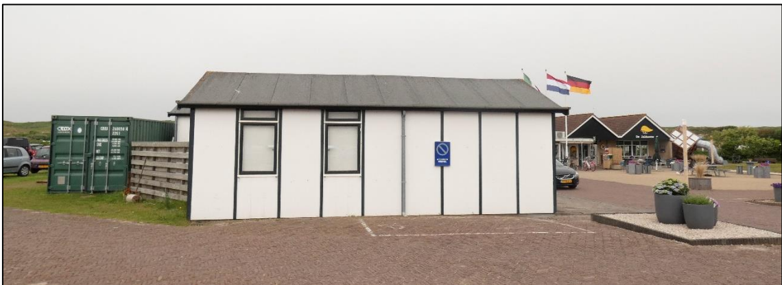
Figuur 3: Twee van de opstallen zijn opgetrokken uit kunststof platen met een plat bitumen dak.
