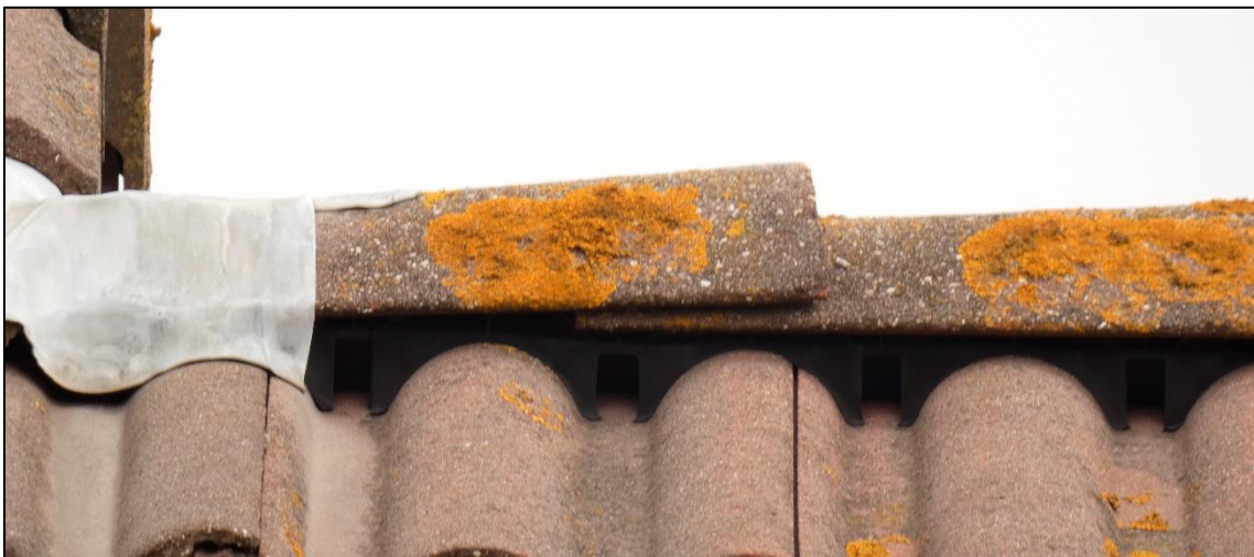
Figuur 12: De dakranden en nokvorsten hebben vogelschroot waardoor vogels niet onder de dakpannen kunnen.
