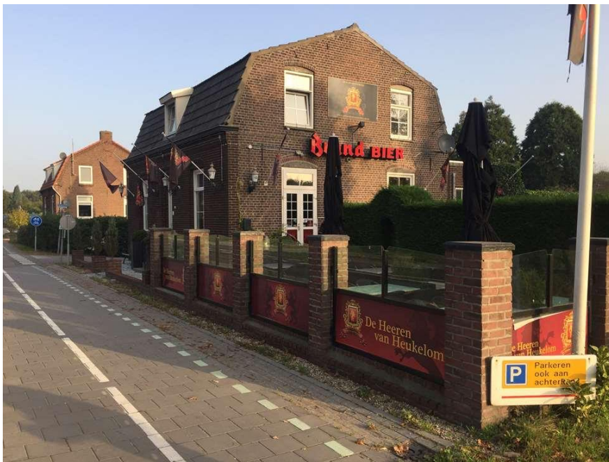
Afbeelding 16. Het café vormt de zuidelijke grens van het trace over de N271. Er zijn verder geen bijzonderheden.
