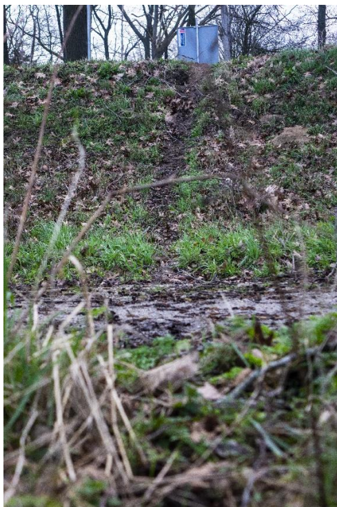
Afbeelding 14 Wissel ter hoogte van de N271, vanuit de uiterwaarden in het westen richting de hogere zandgronden in het oosten
