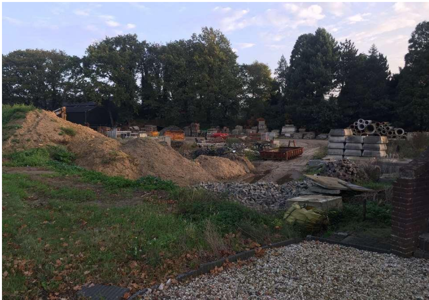
Afbeelding 1. Depot en opslag van bouwmaterialen langs de N271. Het depot ligt gedeeltelijk binnen de projectgrenzen.
