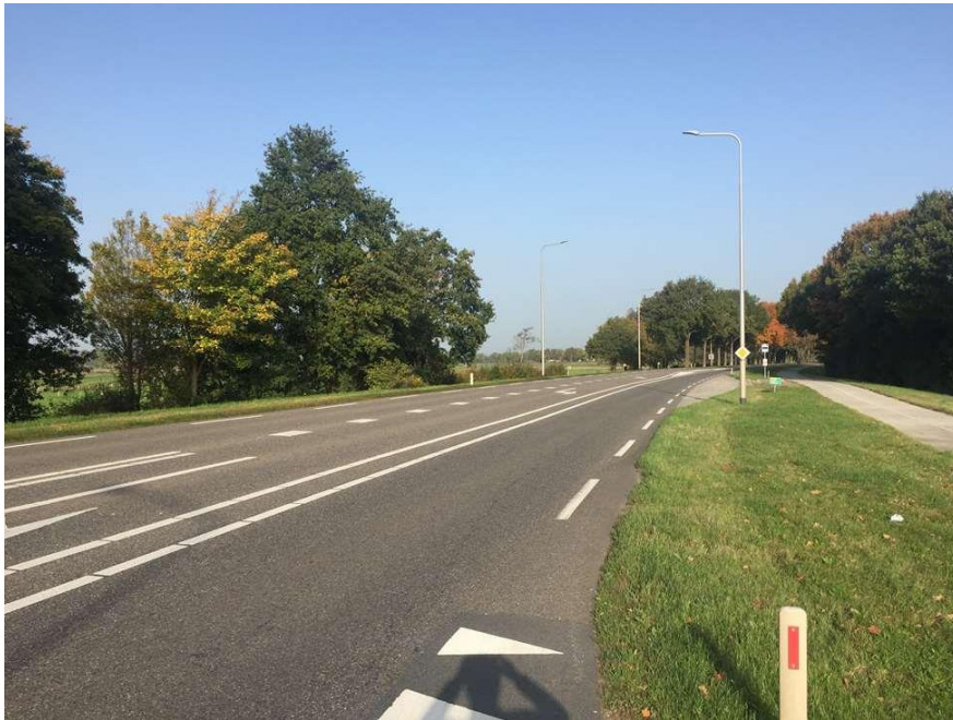
Afbeelding 29. De N271 gezien in noordelijke richting ter hoogte van industrieterrein de Flammert.
