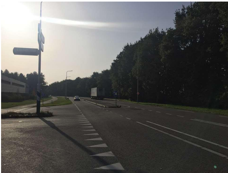
Afbeelding 30. De N271 gezien in zuidelijke richting ter hoogte van industrieterrein de Flammert.
