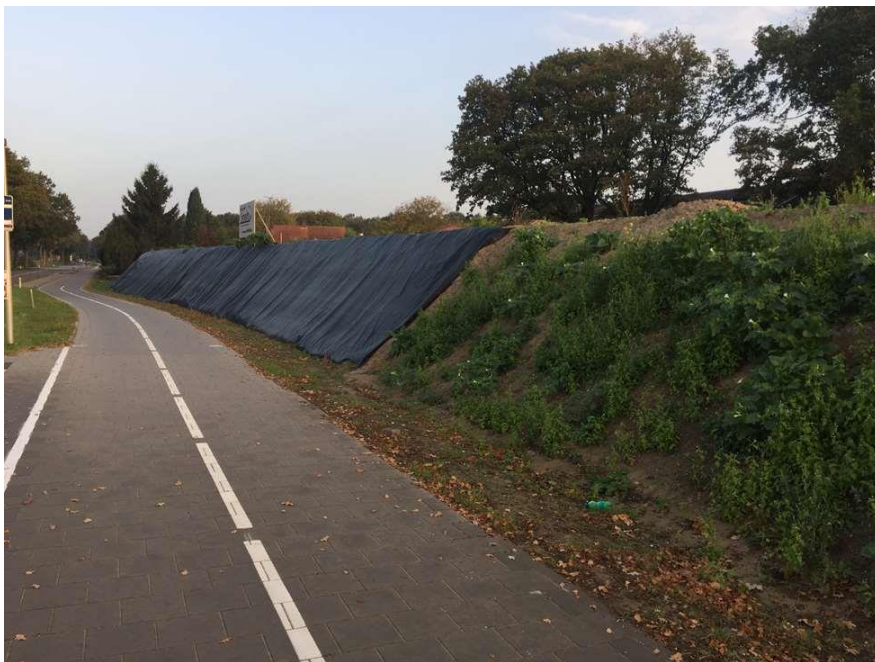
Afbeelding 4. Het depot gezien in noordelijke richting.
