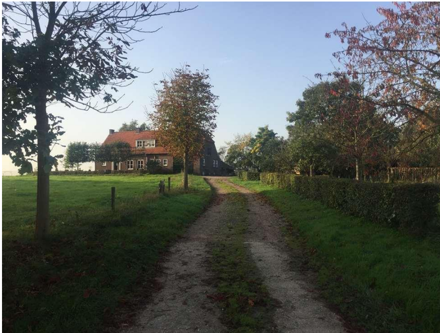
Afbeelding 23. Een boerderij in westelijke richting. Op het terrein is een kleine opslag en een moestuin aanwezig. Daarnaast is mogelijk een van de daken van asbest.
