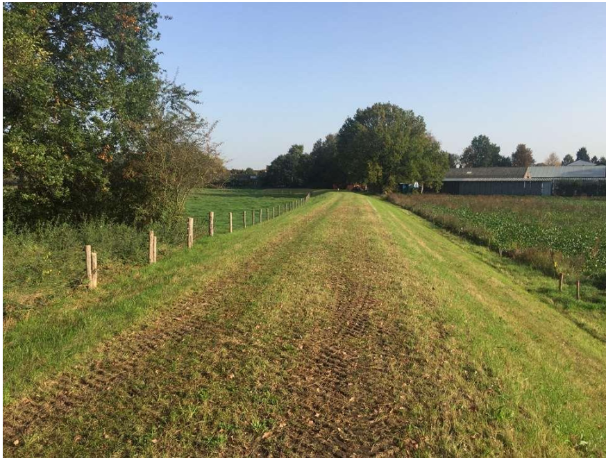
Afbeelding 31. De bestaande dijk gezien in noordoostelijke richting ter hoogte van de Aspergeweg.
