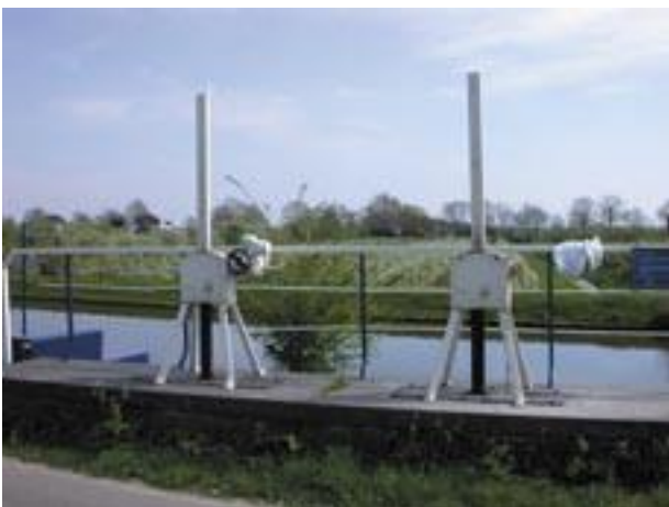
Waterbouwwerk langs de Hollandse IJssel tzv. Hekendorp
