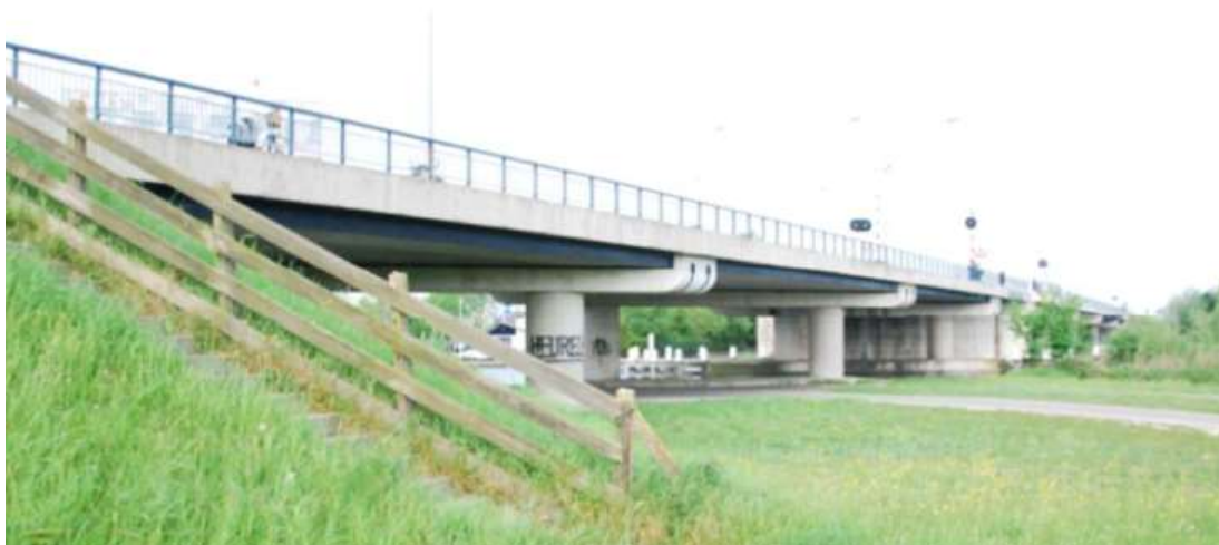
Figuur 6: Aanzicht van de bestaande brug
