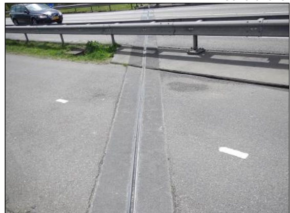
Voegovergang; Afdichtingsprofiel
