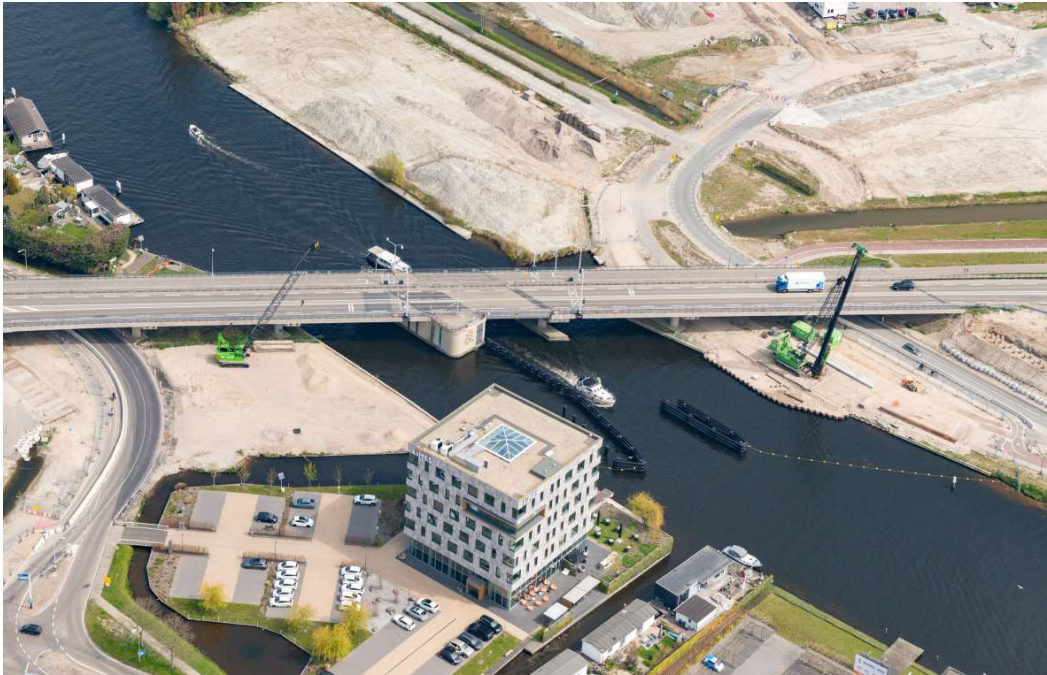
Figuur 4:: Luchtfoto oostelijke oever Oude Rijn met bestaande Torenvlietbrug en nieuw remmingwerk (genomen medio mei 2021)
