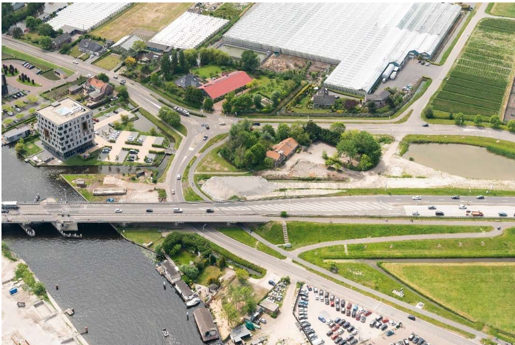
Figuur 5:: Luchtfoto westelijke oever Oude Rijn en bestaande Torenvlietbrug (genomen medio mei 2020)
