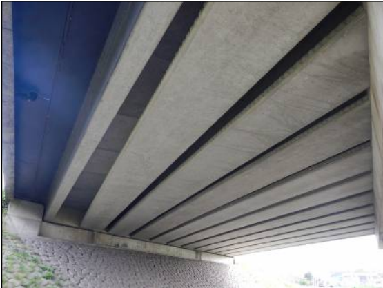
Hoofddraagconstructie; Hoofddraagconstructie, Algemeen (omgekeerde T-ligges OVSP 08-09)
