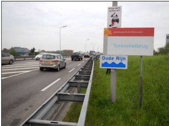
Geleideconstructie; Geleiderail (aarden baan) 50 m breedte 60 en 80 cm
