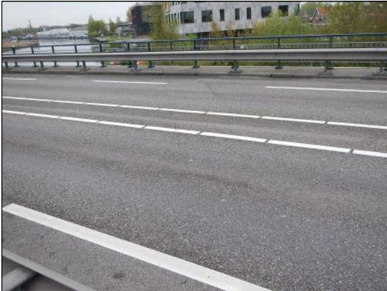
Verharding wegtype 1 (hoofdwegennet); Deklaag (dicht) SMA-NL (SMA)
