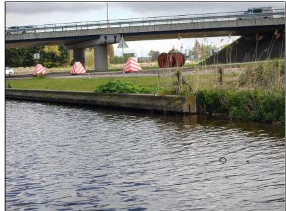
Kerende constructie Stalen damwand met betonnen deksloof
