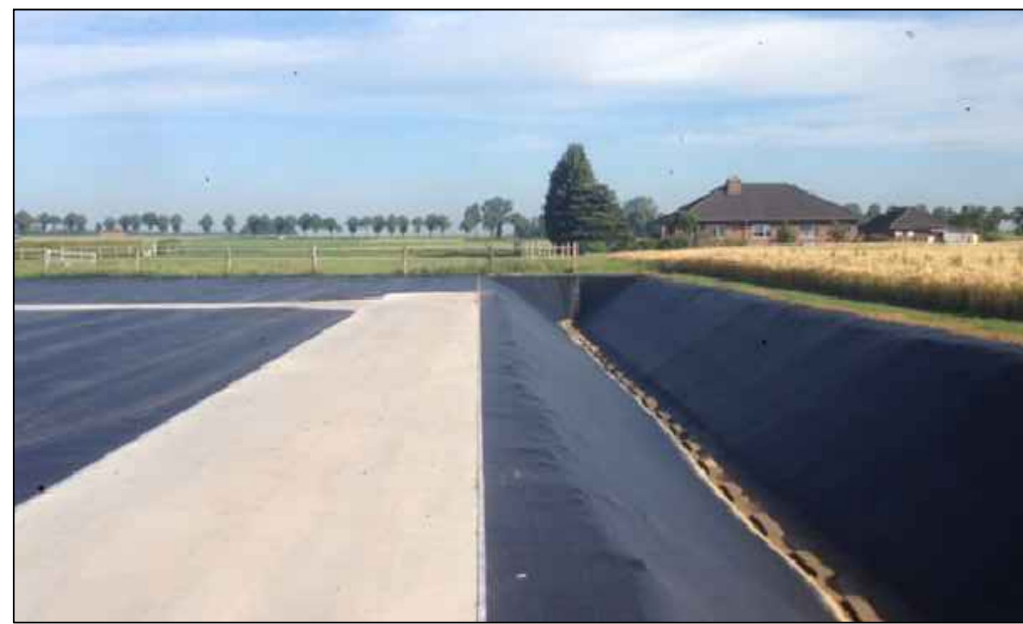
Foto van gedeelte van een trayveld met first flush greppel.
