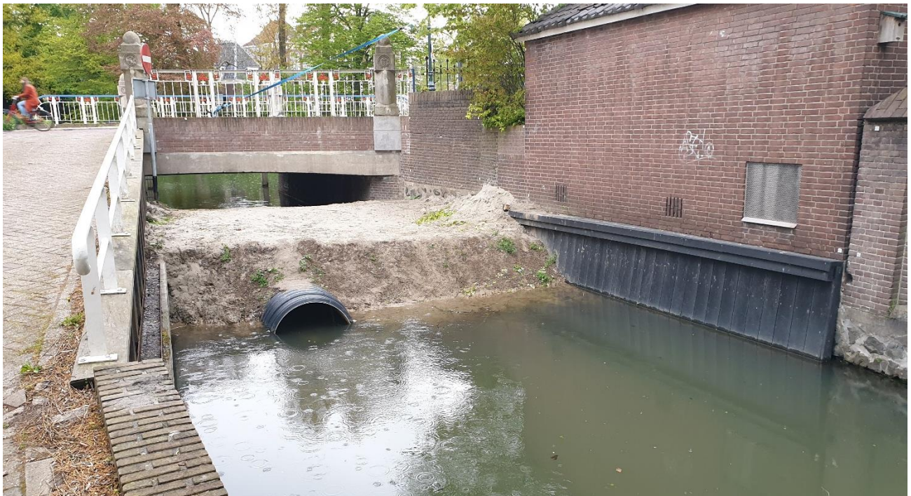
Figuur 2, aanwezige zanddam in Minstream
