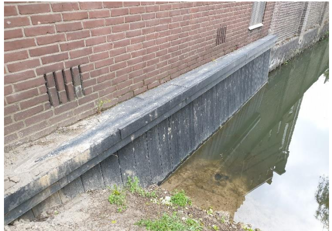
Figuur 6, bestaande kunststof beschoeiing
