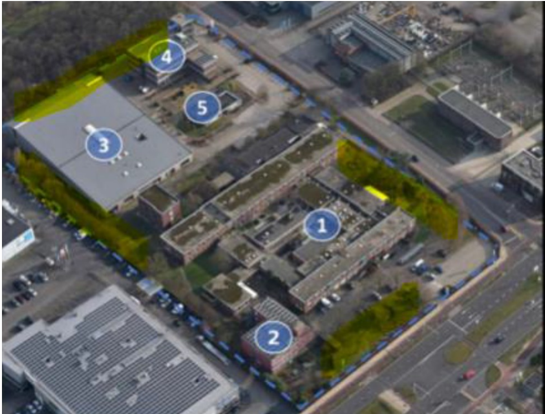
Figuur 4: de aanvullende acht kasten worden geplaatst aan de gevels van gebouw 3 en aan bomen in het geel gearceerde deel (Martens, 2021)
