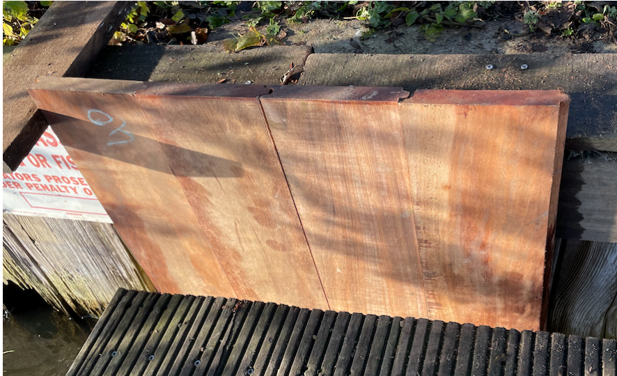
Proef met Azobé planken (komen straks dicht op de oude beschoeiing)
