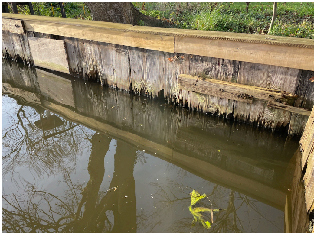
Nieuwe situatie: provisorisch herstelwerk
