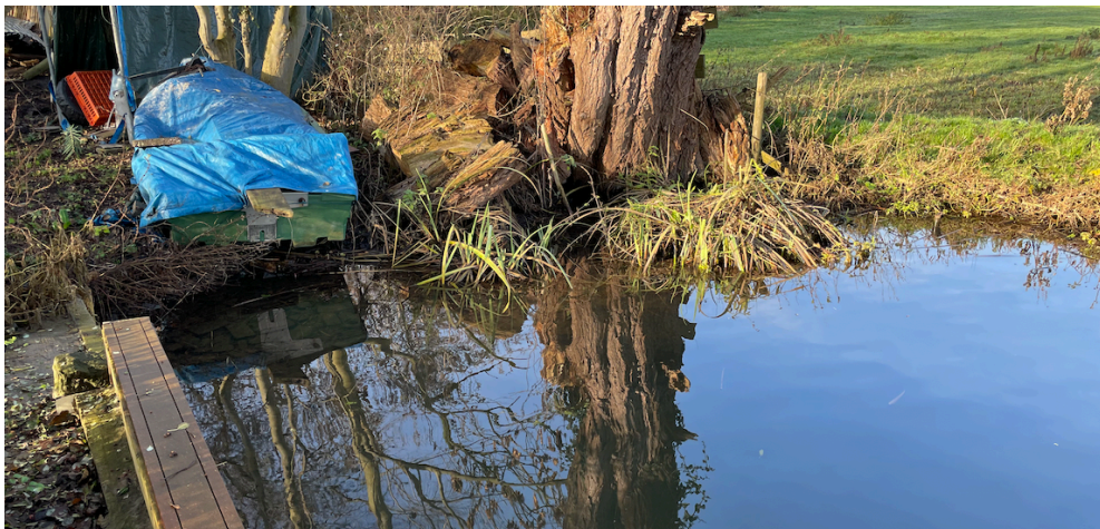
Huidige situatie insteekhaven. Waar de boot ligt wordt 20 cm afgegraven
