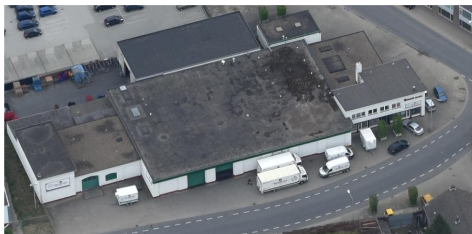
Bestaande karakteristieke bedrijfsgebouwen
