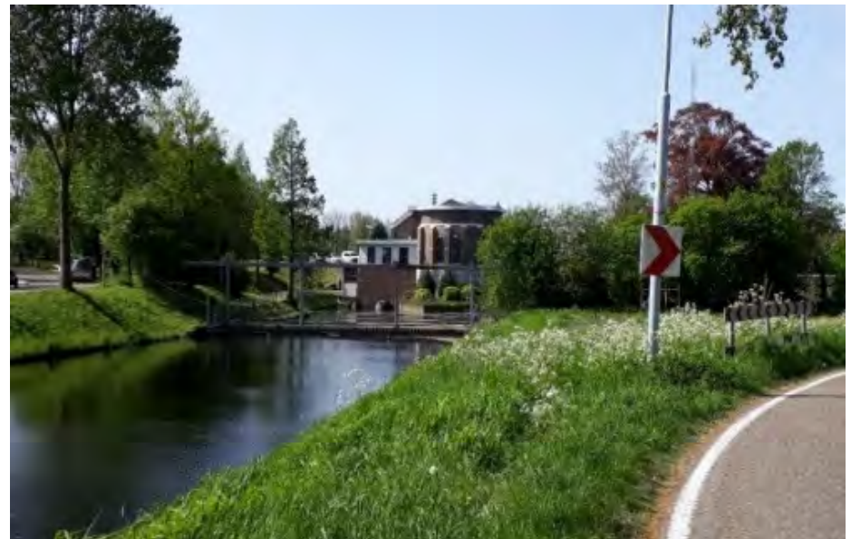
Het gemaal De Leeghwater vanaf de Hoofdweg
