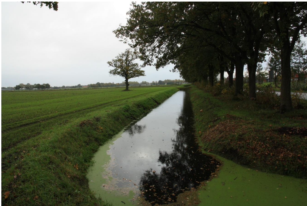
Figuur 3-2: bovenloop Beekerloop langs de Koestraat
