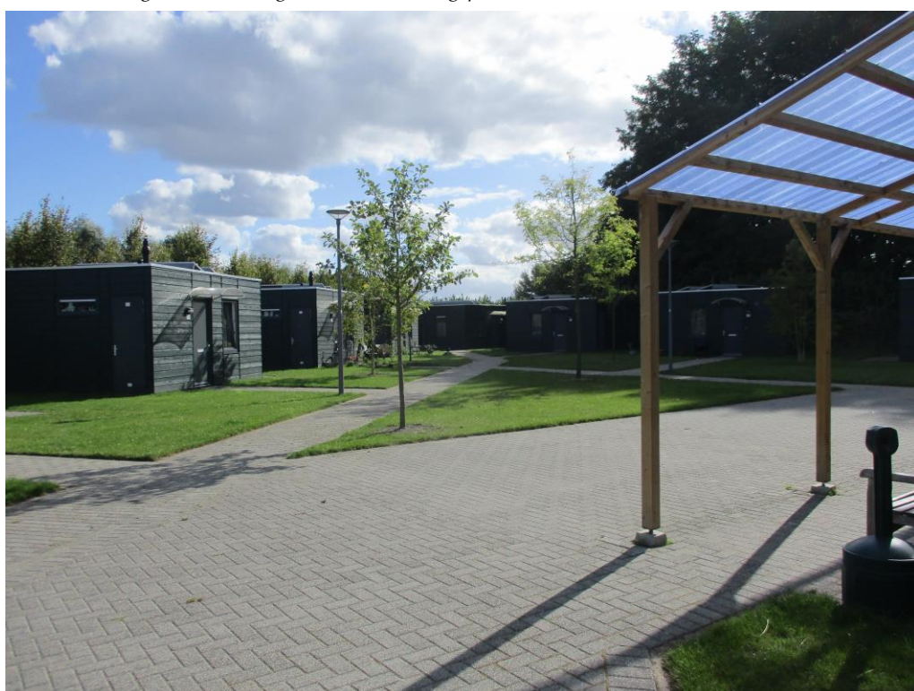
Figuur 2 De woningen binnen de planlocatie. Binnen de beoogde ontwikkelingen worden drie vergelijkbare woningen gerealiseerd. De aanwezige woningen blijven in huidige staat behouden.
