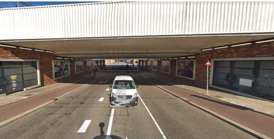
Spooronderdoorgang bij Kruisvaartbrug
