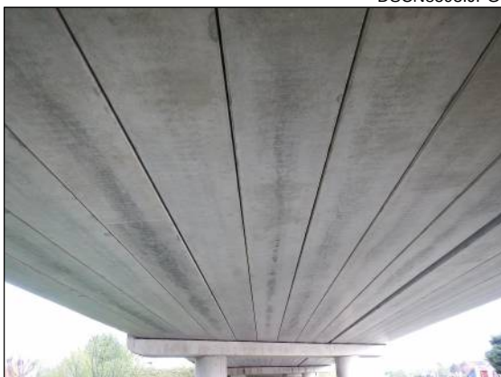
Hoofddraagconstructie; Hoofddraagconstructie, Algemeen (kokers OVSP 01-08)
