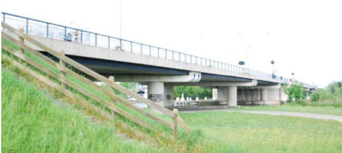
Figuur 14: Aanzicht van de bestaande brug
