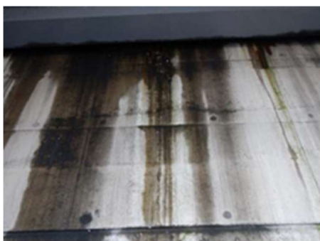
Figuur 25 Scheur in westelijke wand (bevinding 39)
