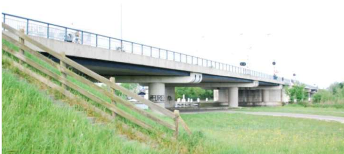
Figuur 6: Aanzicht van de bestaande brug
